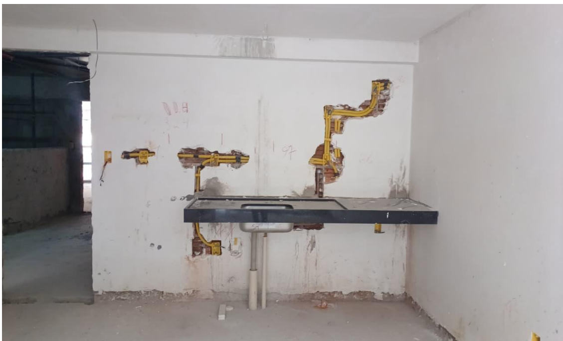
Figura 10 – Reabertura de parede após fechamento completo para ajustes
