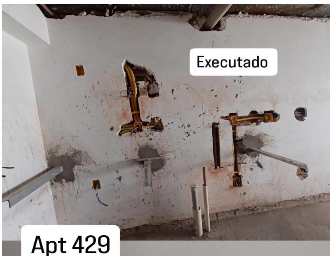
Figura 4 – Execução real dos pontos elétricos e hidrossanitários – Unidade 429
