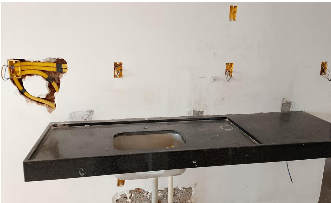
Figura 8 – Retrabalho em parede de gesso após necessidade de correção de pontos
