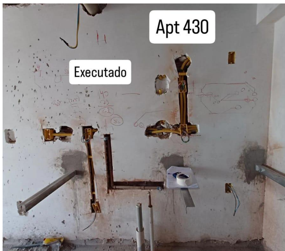
Figura 5 – Execução real dos pontos elétricos e hidrossanitários – Unidade 430
