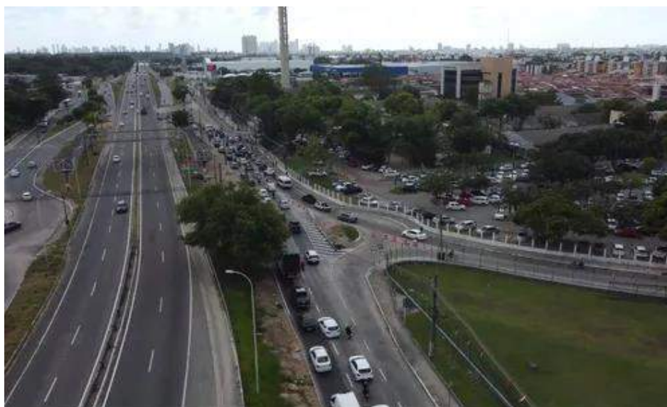
Figura 12 – Foto sobre BR-230 nas proximidades do Viaduto de Prefeito Luciano Agra.
