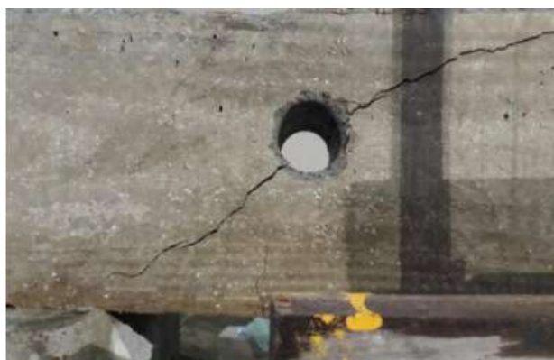
Figura 17 - Fissura tipo feixe decorrente a abertura na alma da viga
