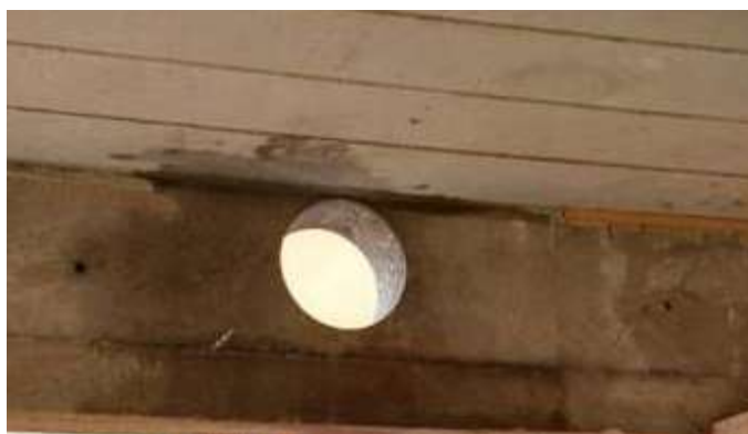
Figura 18 - Furo com grande dimensão em relação à altura da viga
