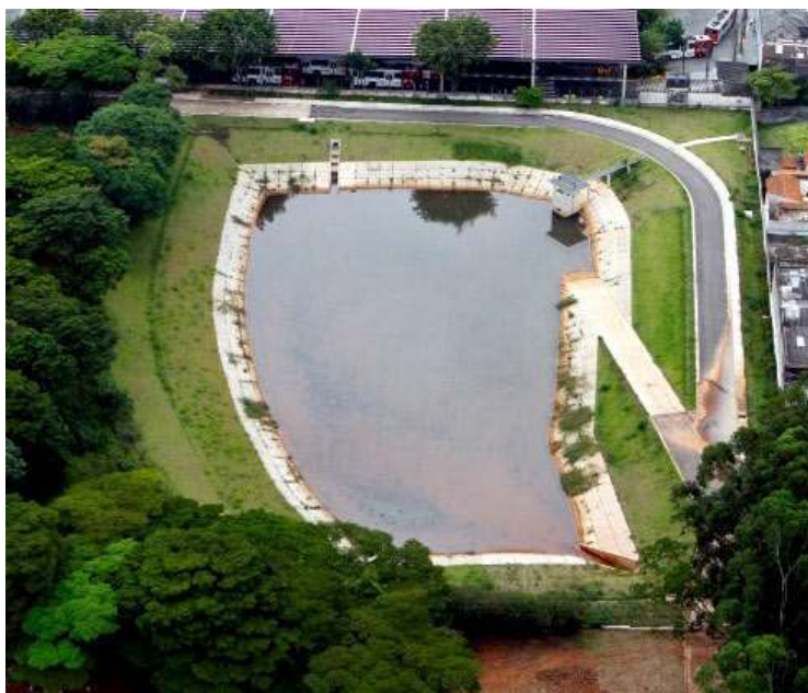
Figura 7 - Reservatório de retenção.
