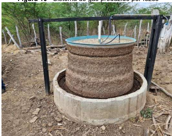
Figura 10 - Sistema de gás produzido por fezes
