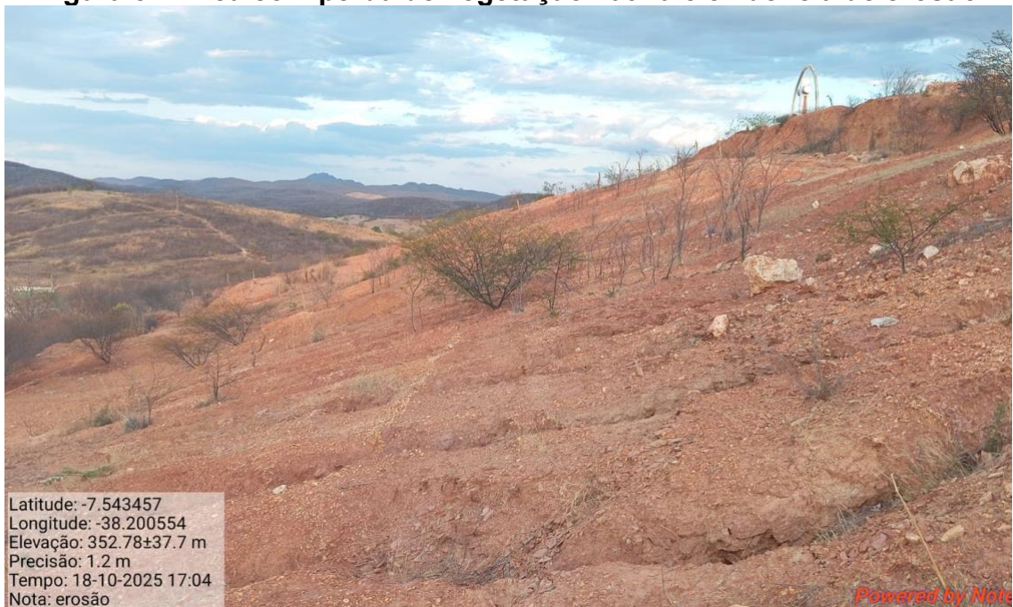
Figura 8 – Área com perda de vegetação nativa e evidência de erosão
