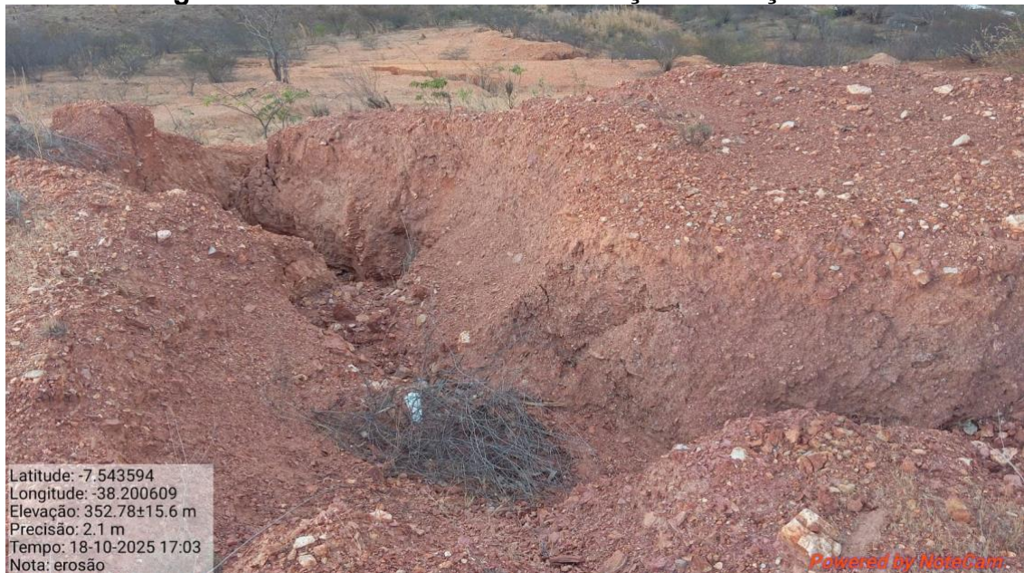
Figura 11 - Erosão Hídrica e Formação de Voçorocas.
