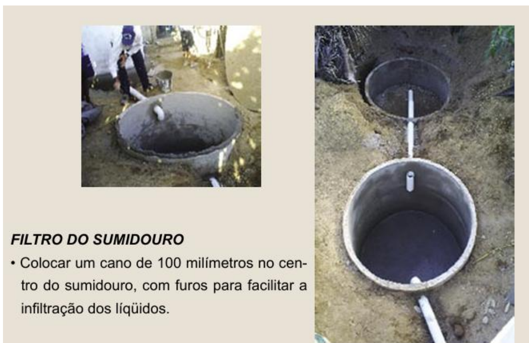
Figura 4 - Etapa de construção dos banheiros da cartilha DIACONIA.
