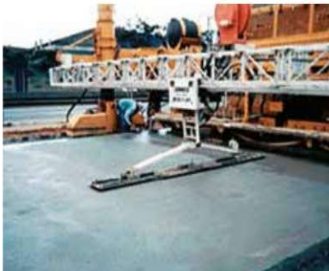
Figura 9 - Execução das placas de concreto cimento
