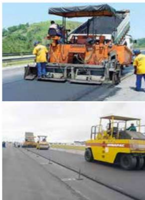
Figura 4 - Execução do revestimento asfáltico
