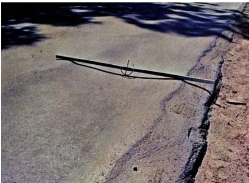
Figura 17 - Afundamento plástico
