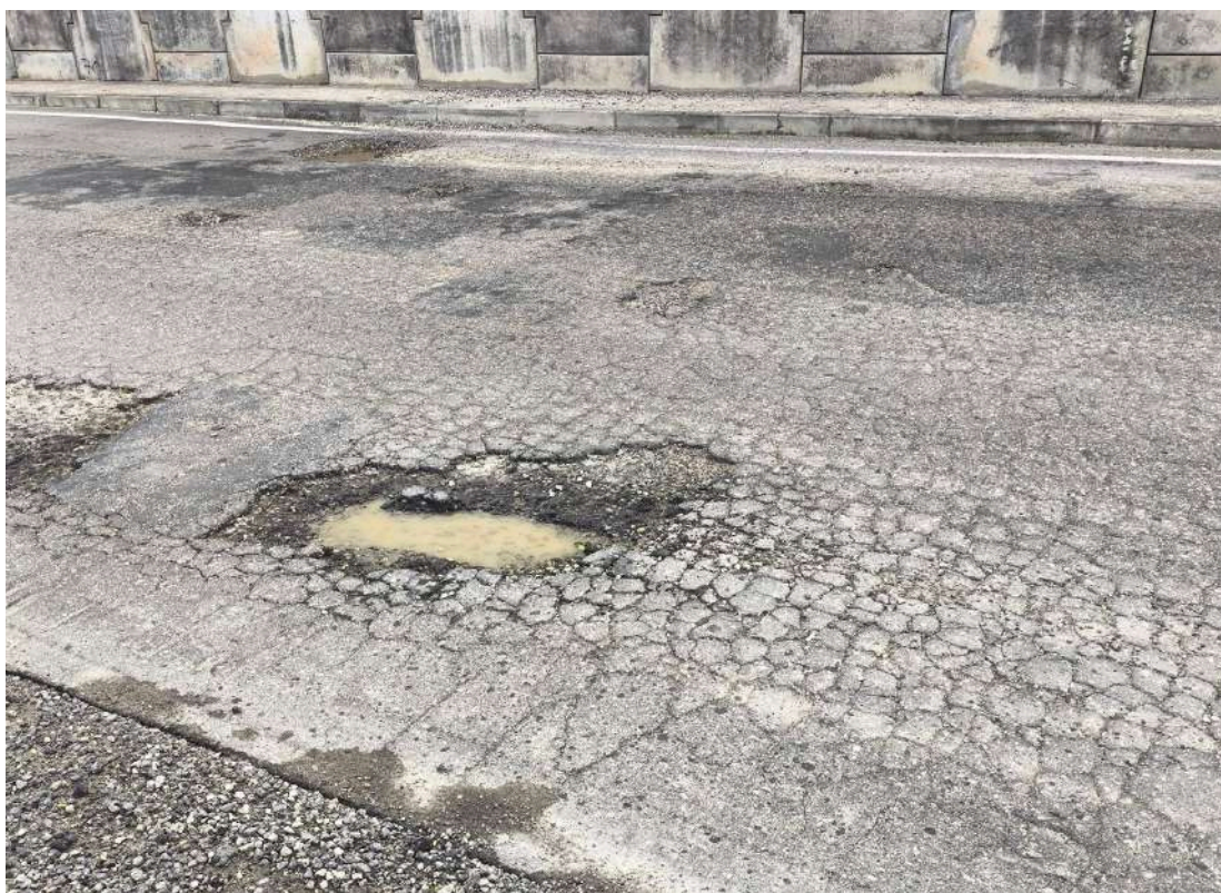
Figura 28- Trinca Jacaré
