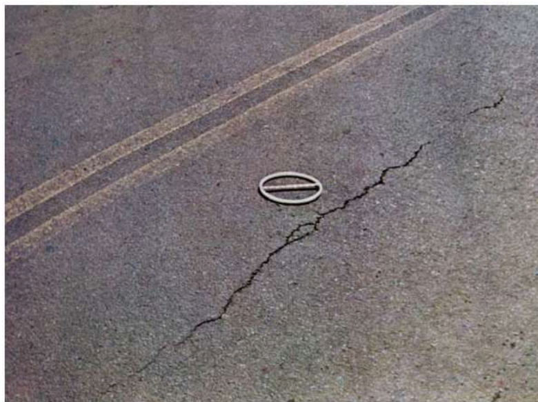
Figura 13 - Trinca longitudinal
