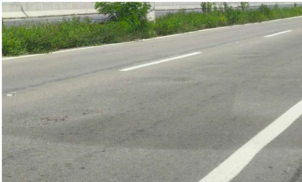
Figura 32 - Ondulações
