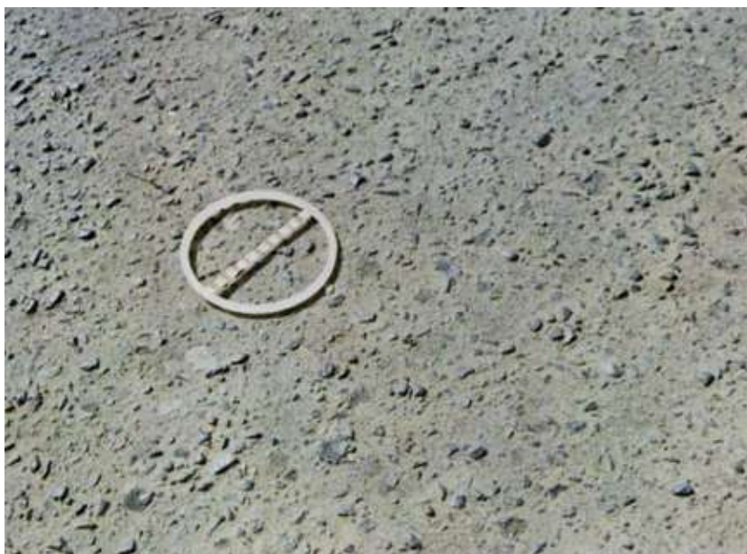
Figura 22 - Desgaste
