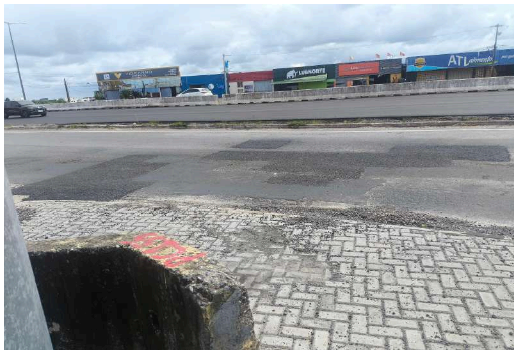
Figura 37 - Remendos
