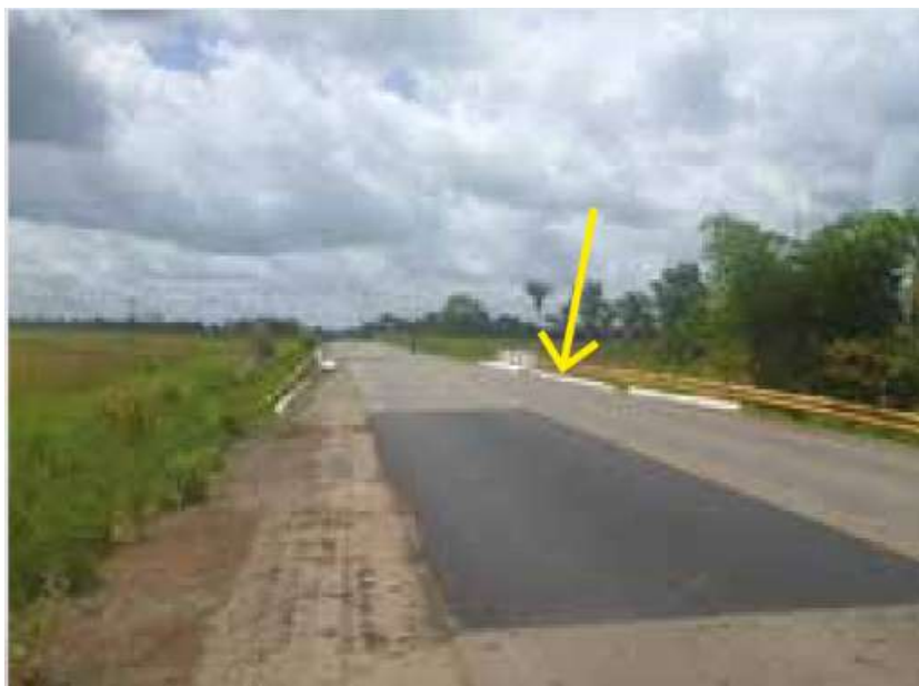
Figura 24 - Remendo
