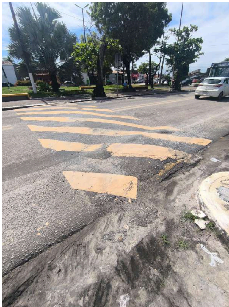
Figura 30- Afundamento Plástico
