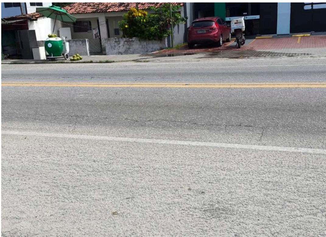
Figura 27- Trinca Longitudinal
