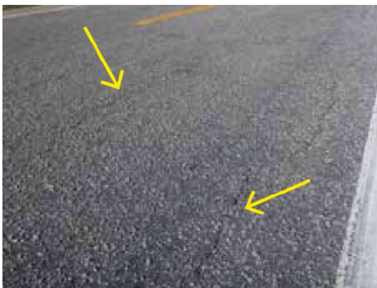
Figura 11 - Fissura
