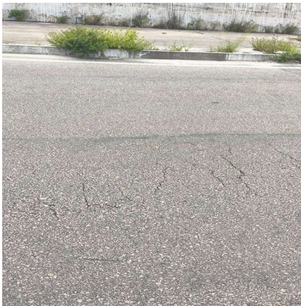
Figura 26 - Trinca Transversal
