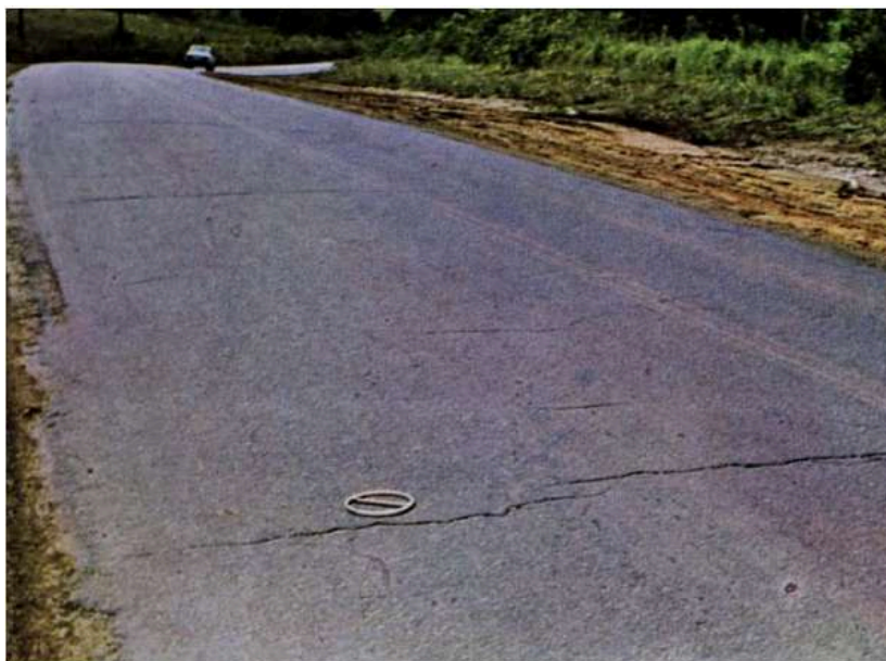
Figura 12 - Trinca transversal
