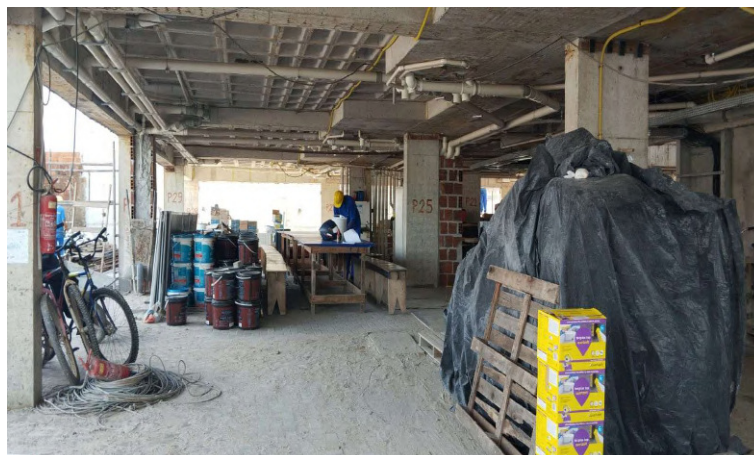
Figura 3 – Armazenamento de materiais e área de vivência
