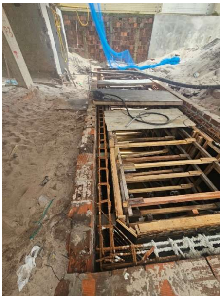
Figura 6 – Execução da fossa séptica
