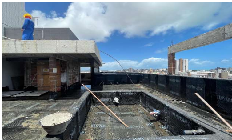
Figura 7 – Execução da impermeabilização da área gourmet
