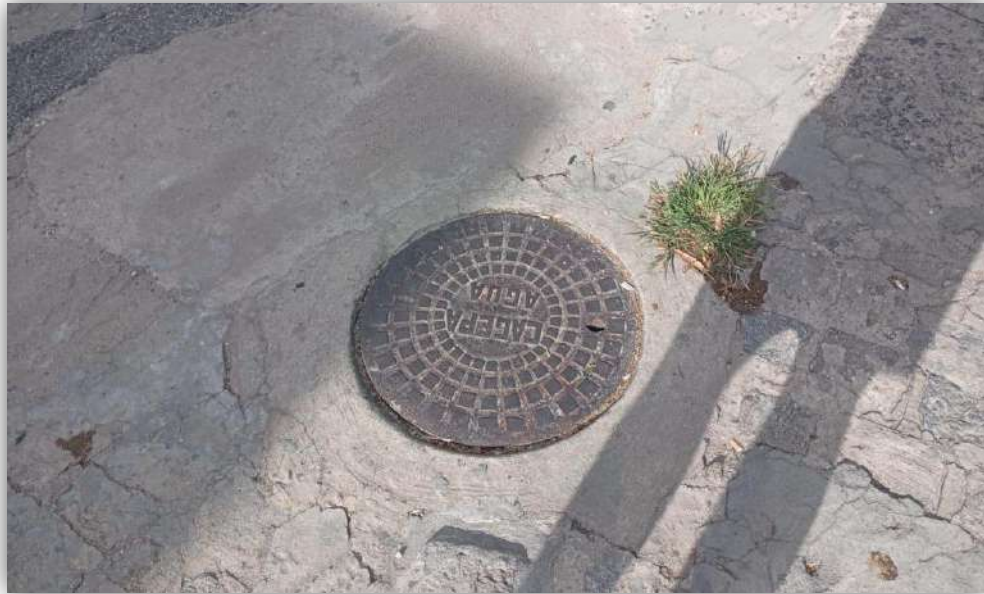
Figura 24 - Poço de visita da rede de drenagem pluvial implantado em área pavimentada
