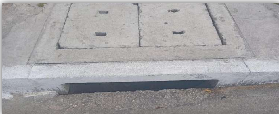
Figura 29 - Boca de lobo simples em concreto localizada junto ao meio-fio
