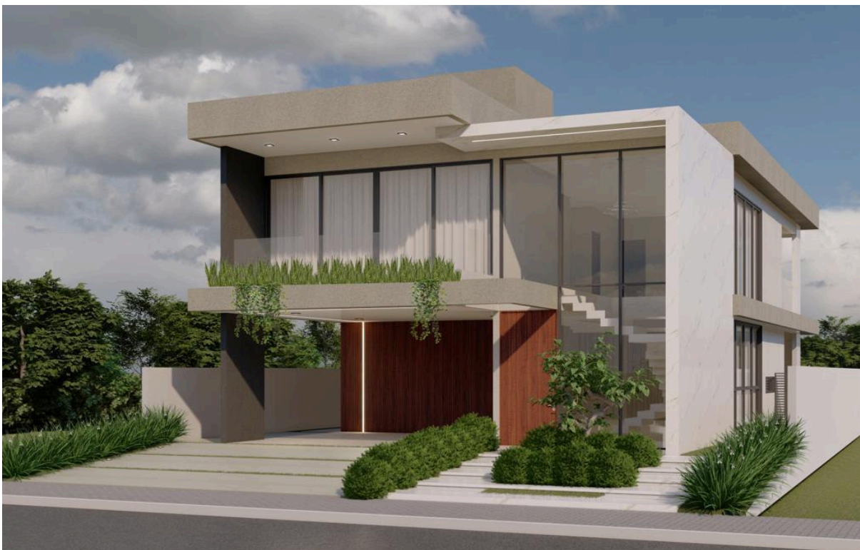
Figura 4 - Vista da fachada leste e da lateral norte da edificação
