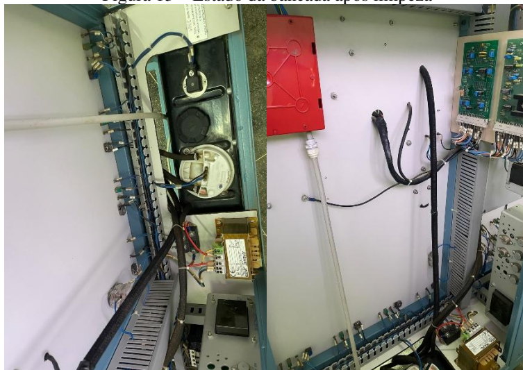
Figura 13 – Estado da bancada após limpeza
