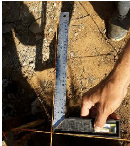
Figura 2.13 – Esquadro que os pedreiros geralmente utilizam
