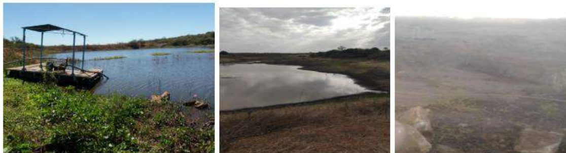
Figura 12 - Processo de gradativo de secagem da barragem após seca severa
