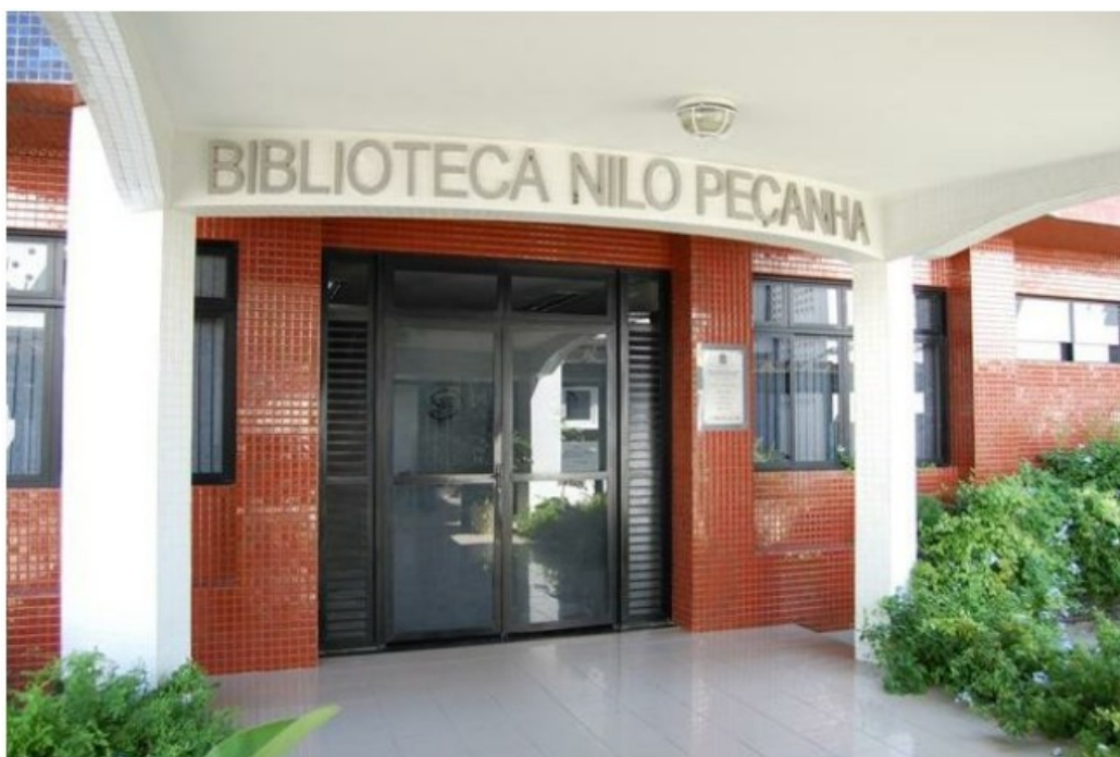
Figura 4.1: Vista frontal da Biblioteca Nilo Peçanha.
