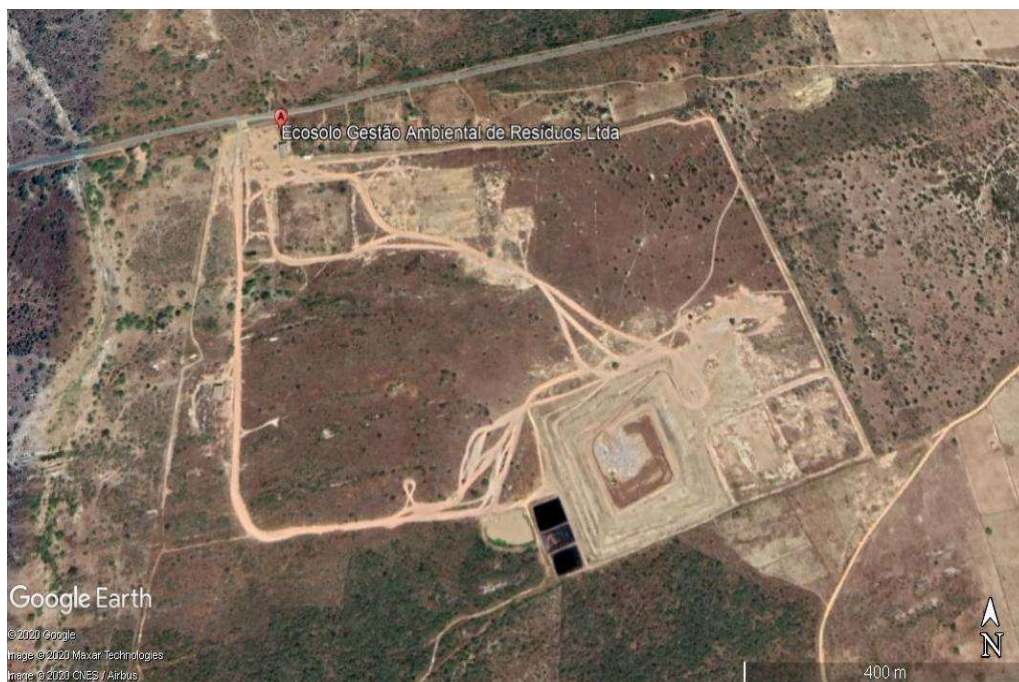
Figura 10: Aterro Sanitário, Catolé de Boa Vista, Campina Grande-PB.
