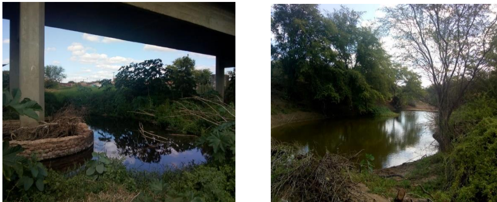
Figura 11,12: Acúmulo de esgoto residual
