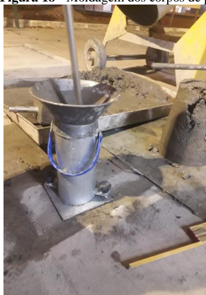
Figura 18 - Moldagem dos corpos de prova
