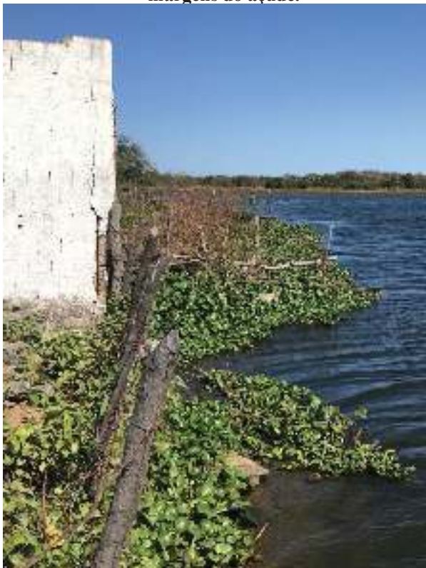
Figura 20 – Muro de uma construção levantada as margens do açude.
