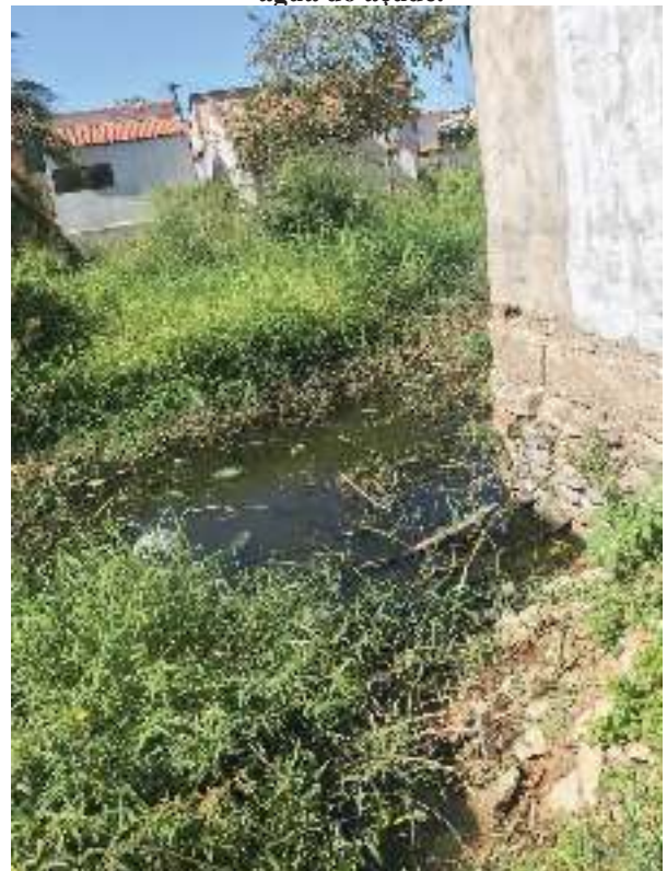
Figura 21 – Fundação da residência em contato com a água do açude.
