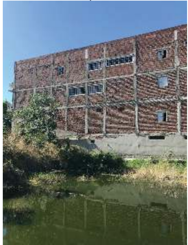
Figura 19 – Prédio erguido próximo às margens do açude.
