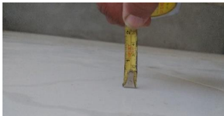
Figura 48 – Desnível superior ao necessário.
