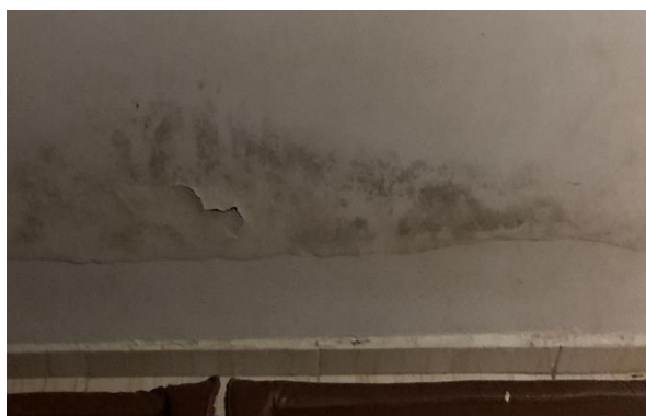
Figura 52 – Destacamento de pintura.
