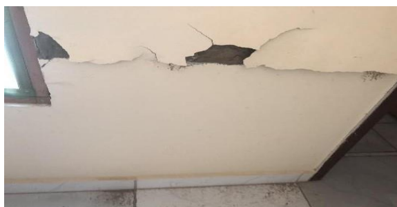
Figura 49 – Fissuras e trincas próximo a janelas.
