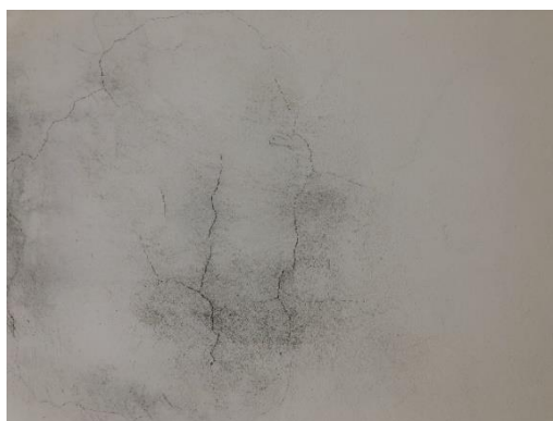
Figura 53 – Presença de mofo.
