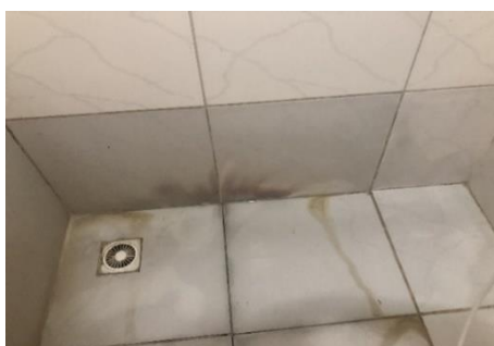
Figura 46– Manchas de absorção.
