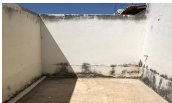
Figura 50 - Infiltração nas partes inferiores das paredes.
