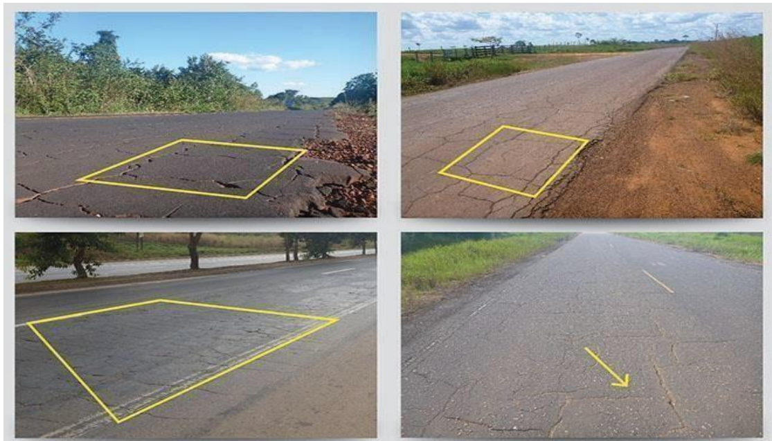
Figura 7- Trinca tipo "Bloco"
