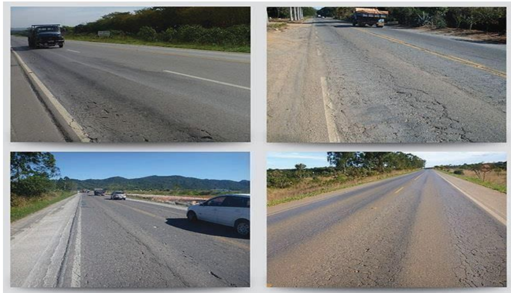
Figura 9- Afundamento de Consolidação
