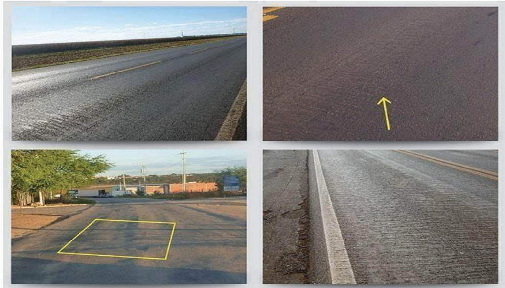
Figura 10- Ondulação ou Corrugação
