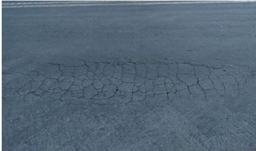
Figura 22- Manifestação Patológica: Trinca tipo “Couro de Jacaré”
