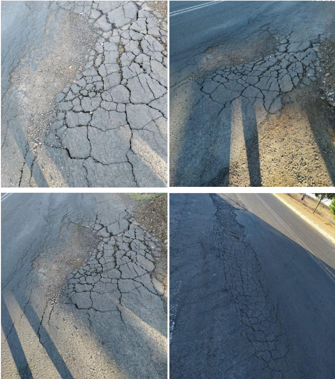
Figura 23- Manifestação Patológica: Trinca tipo “Bloco”
