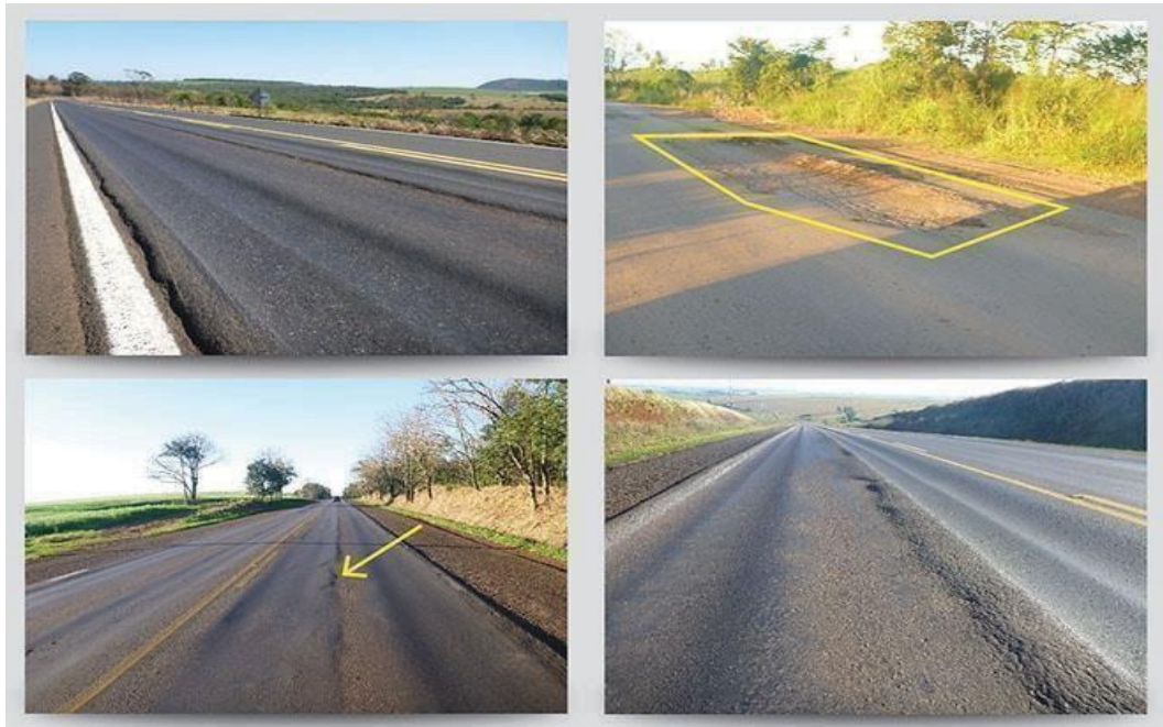
Figura 8- Afundamento Plástico
