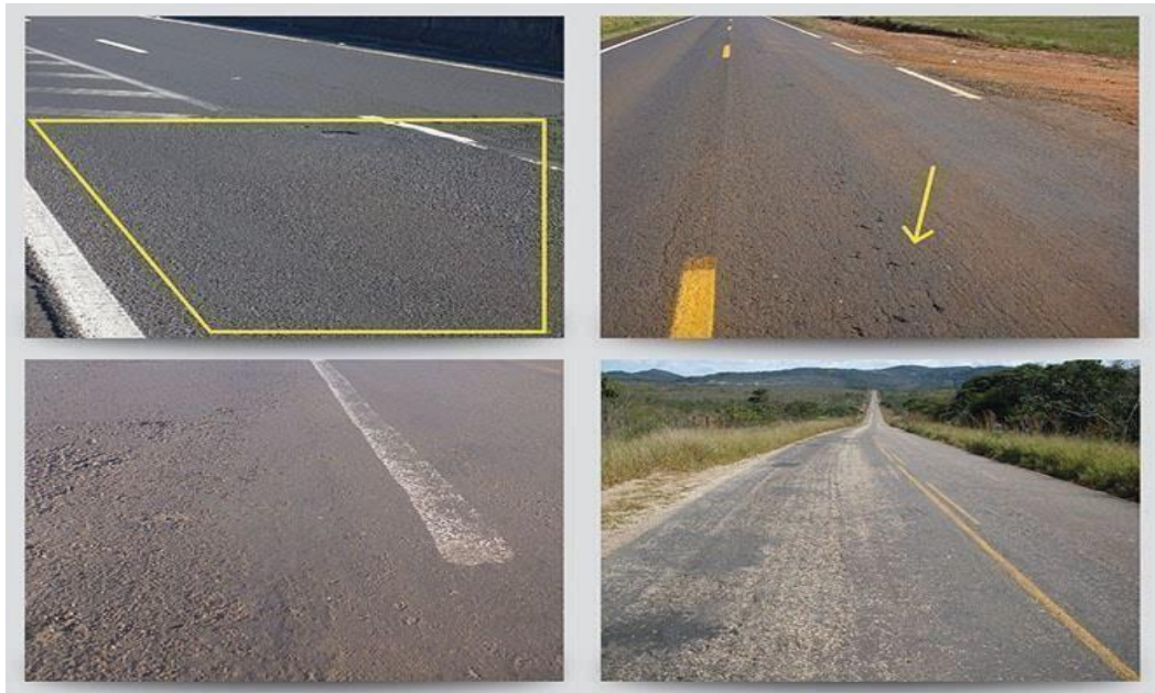
Figura 13- Desgaste
