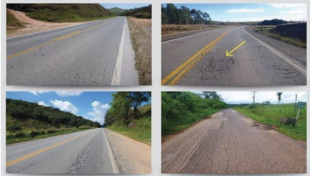
Figura 6 - Trinca tipo "Couro de Jacaré"
