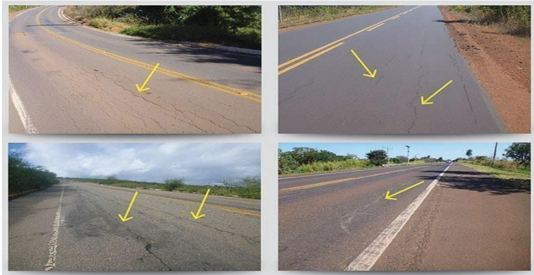
Figura 5-Trinca Isolada Longitudinal
