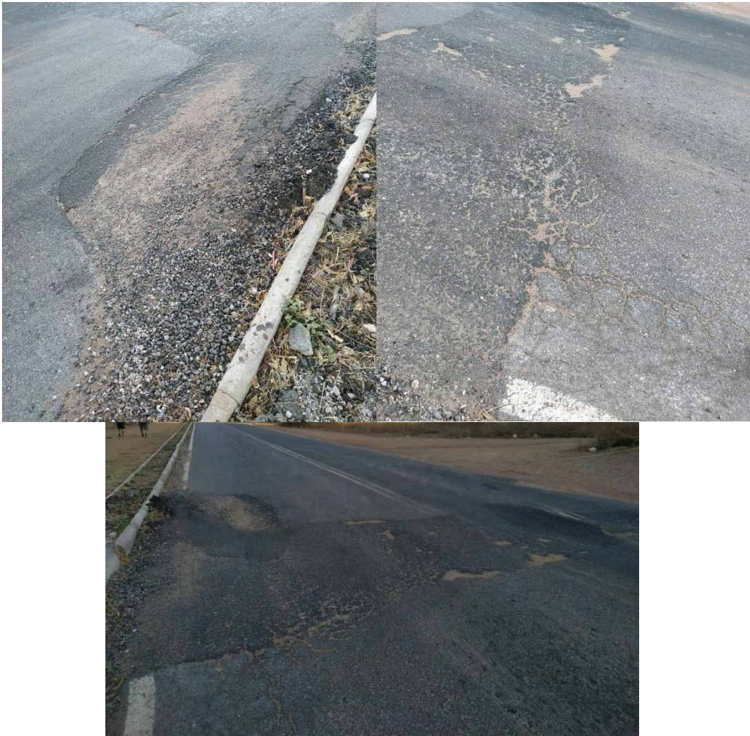
Figura 20- Manifestação Patológica: Remendo
