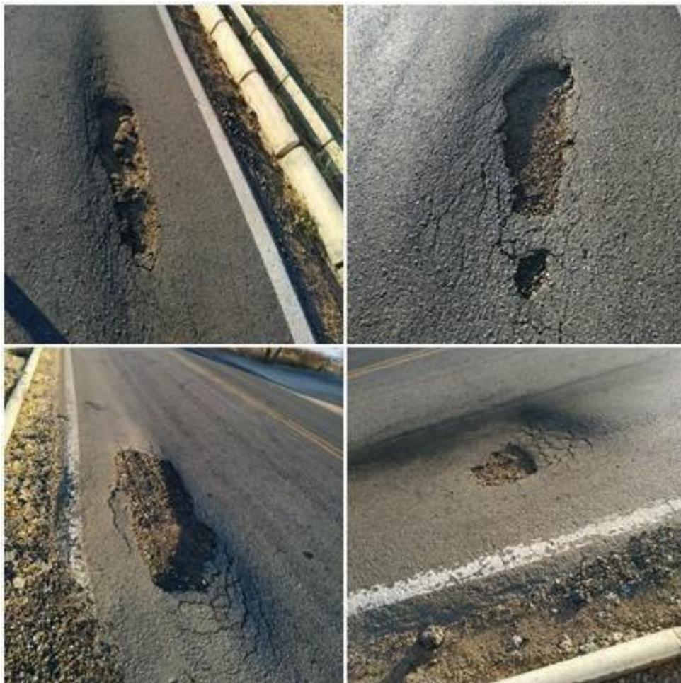
Figura 19- Manifestação Patológica: Panela
