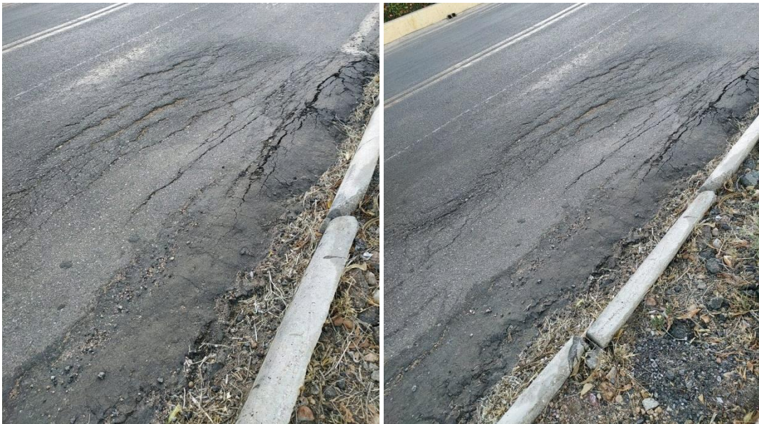
Figura 21- Manifestação Patológica: Trincas Longitudinais
