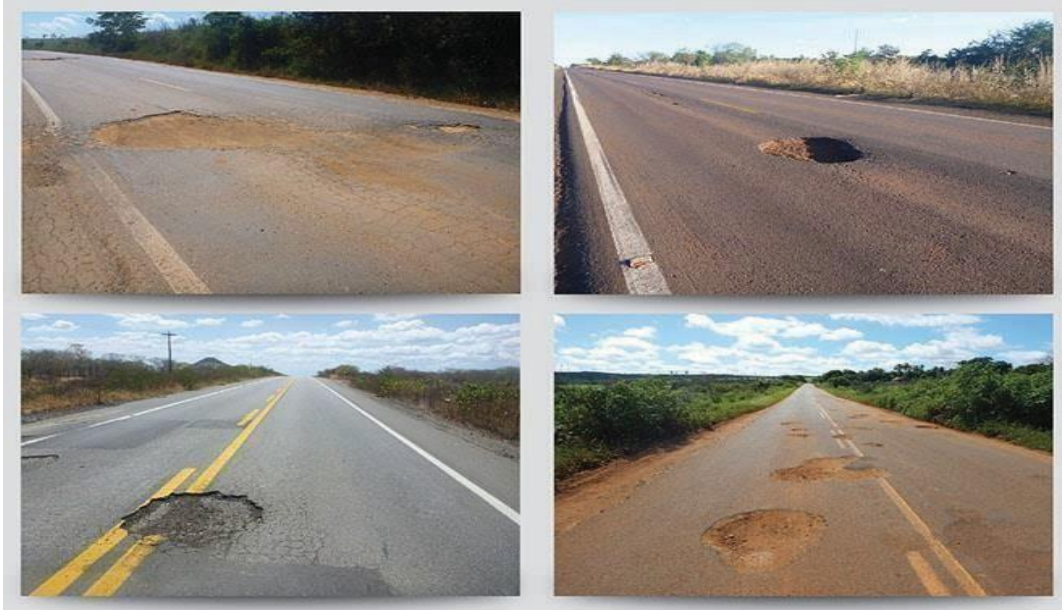
Figura 14- Panela ou Buraco
