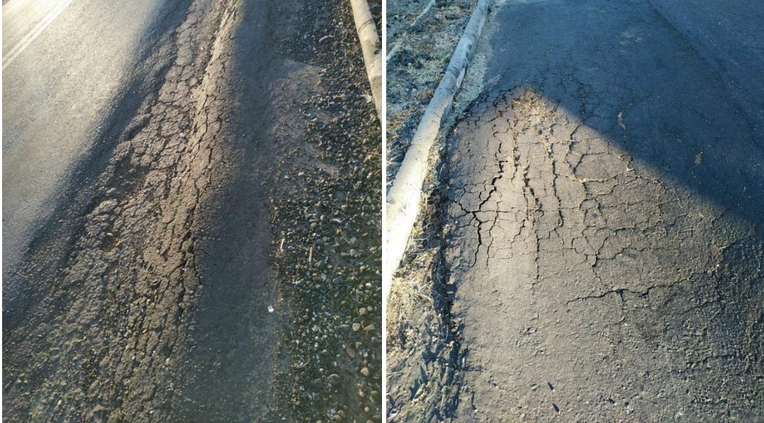
Figura 24- Manifestação Patológica: Afundamento plástico
