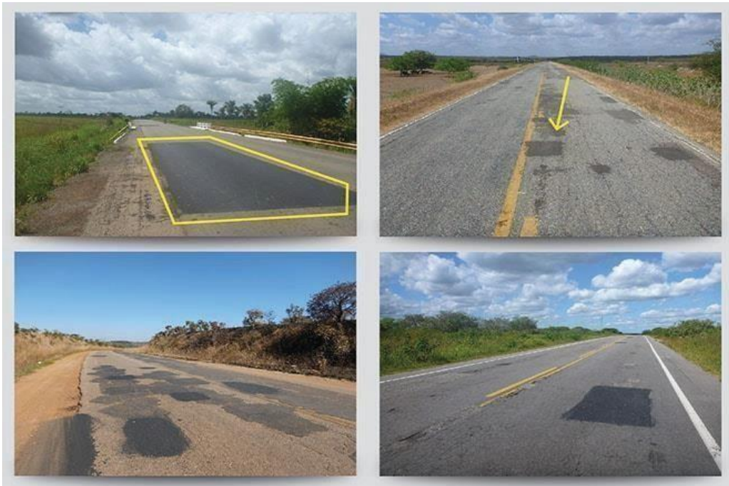
Figura 15- Remendo
