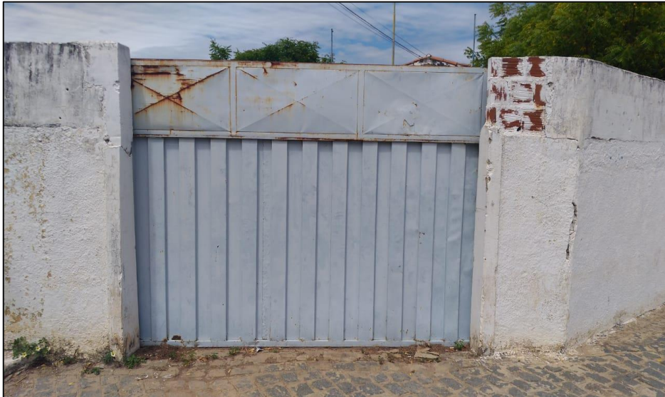
Figura 6 – Portão de acesso da edificação.
