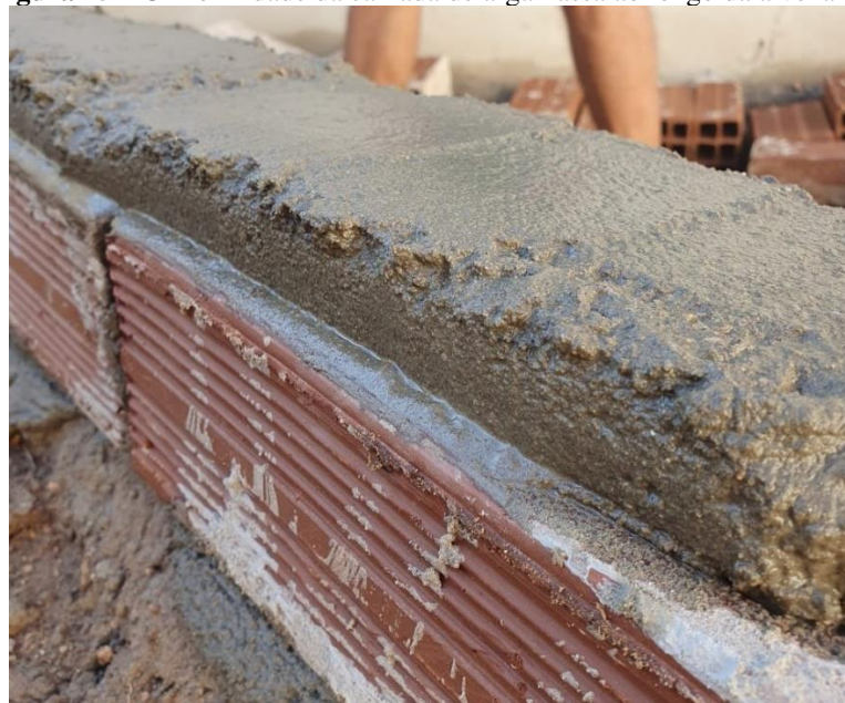
Figura 15 – Uniformidade da camada de argamassa ao longo da alvenaria.
