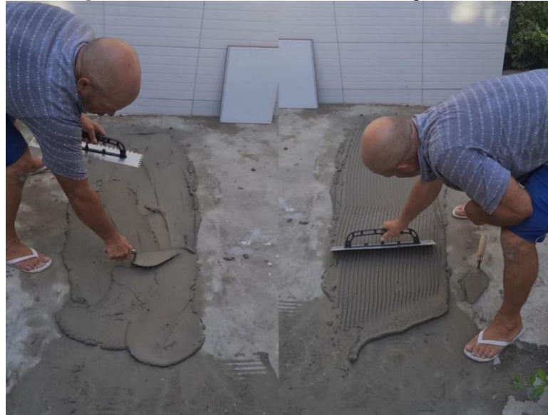
Figura 18 – Método tradicional com a desempenadeira.
