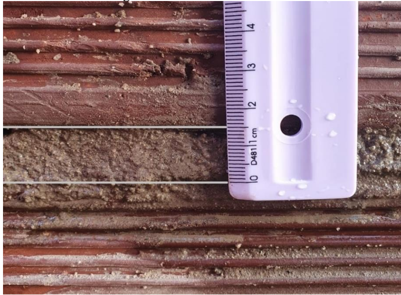
Figura 16 – Junta horizontal final.
