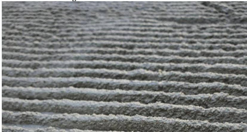
Figura 23 – Vista lateral dos cordões.
