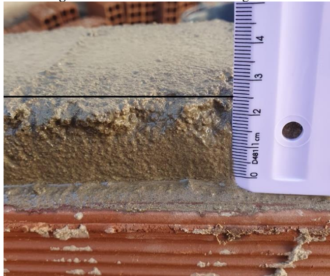
Figura 14 – Altura da camada de argamassa.
