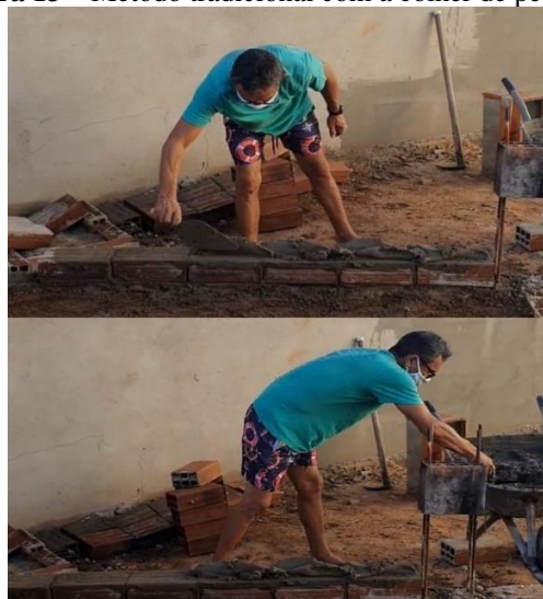
Figura 13 – Método tradicional com a colher de pedreiro.
