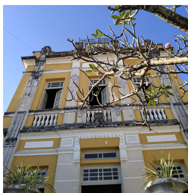
Figura 8: Fachada do Hotel Globo
