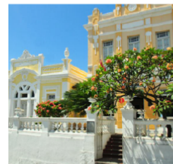
Figura 25: Entrada do Hotel Globo
