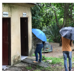
Figura 27: Acesso ao sanitário da Bica
