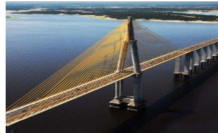
Ponte de concreto protendendo
