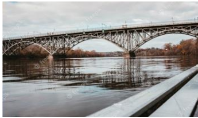
Ponte de aço
