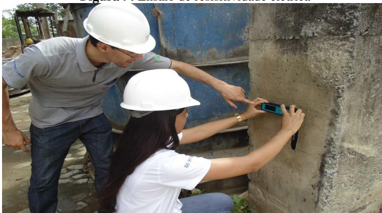
Figura 9: Ensaio de resistividade elétrica
