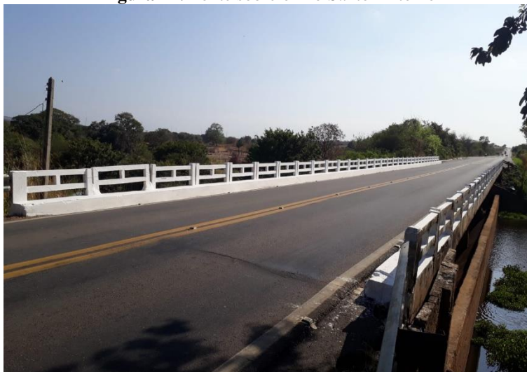
Figura 11: Ponte sobre o Rio Santo Antônio
