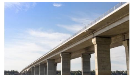
Ponte de concreto armado
