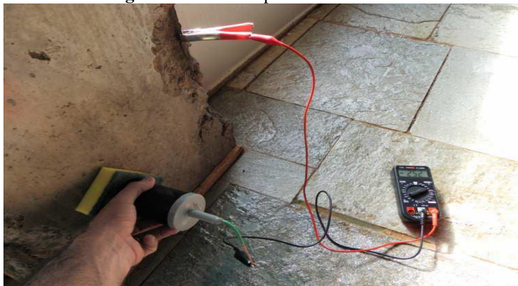
Figura 8: Ensaio de pontencial de corrosão
