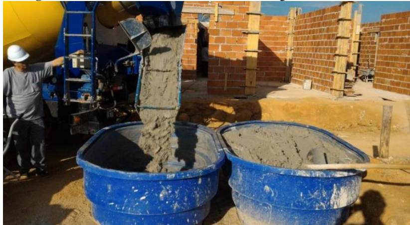
Figura 5 - Recebimento e armazenamento da argamassa estabilizada.
