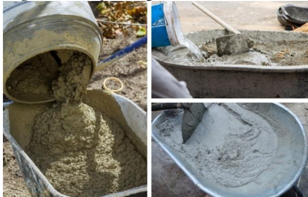
Figura 1 - Produção de argamassa convencional in loco .
