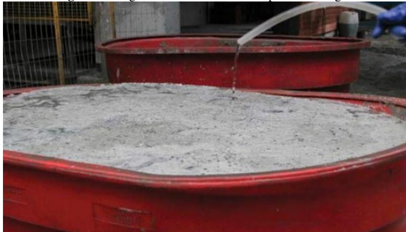
Figura 6 - Argamassa estabilizada com película de água.
