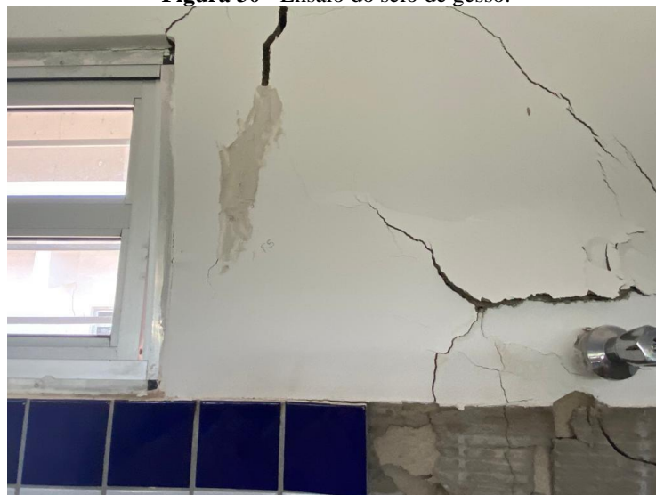
Figura 30 - Ensaio do selo de gesso.
