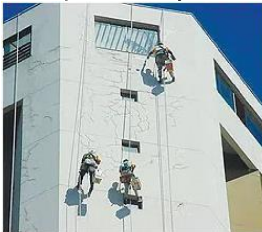
Figura 11 - Fissuras mapeadas.
