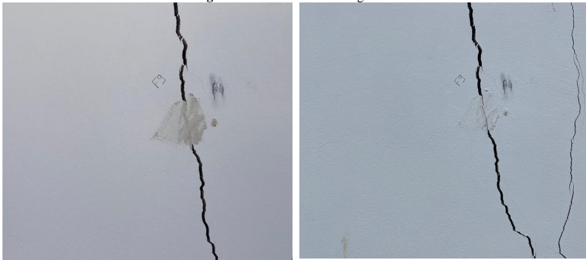
Figura 64 – Ensaio do selo de gesso.
