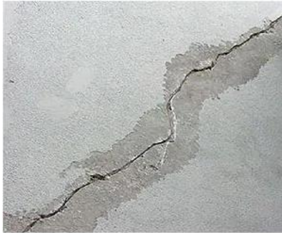
Figura 12 - Fissura geométrica.
