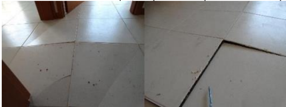
Figura 16 - Deslocamento do revestimento do piso, sob ação de sua dilatação térmica ou da contração térmica.
