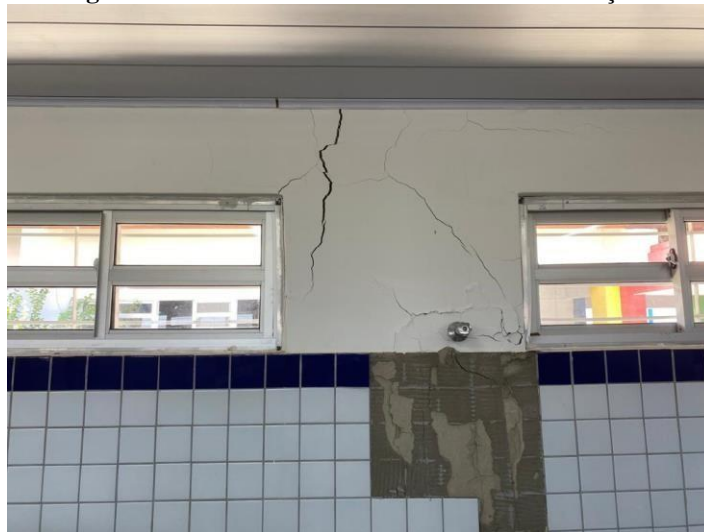
Figura 61 - Aberturas disseminadas em várias direções.
