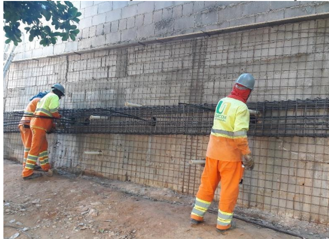
Figura 57 - Reforço de alvenaria com tirante de aço.
