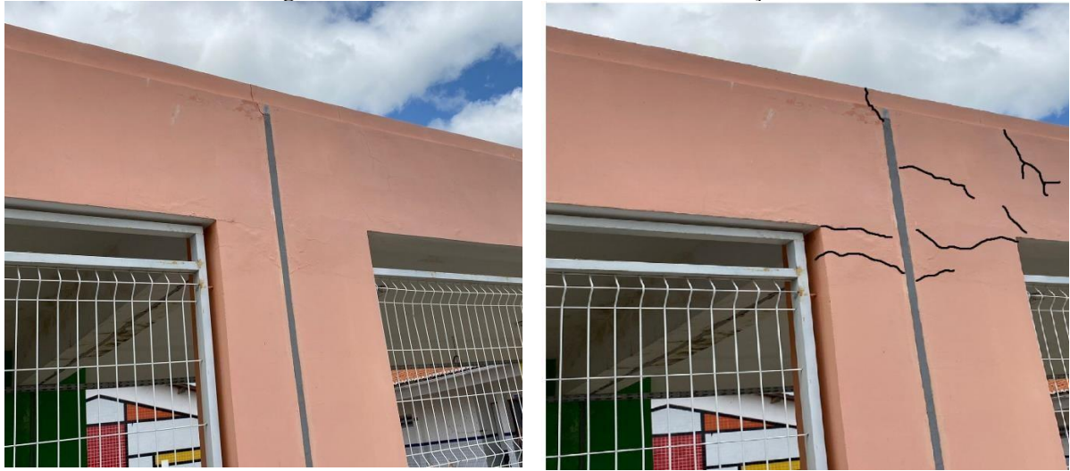
Figura 62 - Aberturas disseminadas em várias direções.
