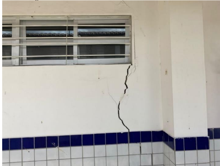
Figura 32 - Fenda vertical sob os vãos de abertura.
