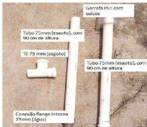
Figura 27. Construção do overflow.
