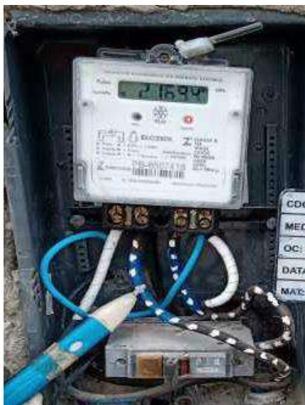
Figura 14 – Ligação invertida em um medidor digital.
