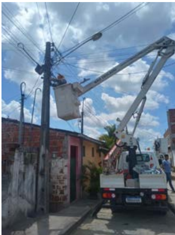
Figura 30 - Retirada do conjunto de IP antigo
