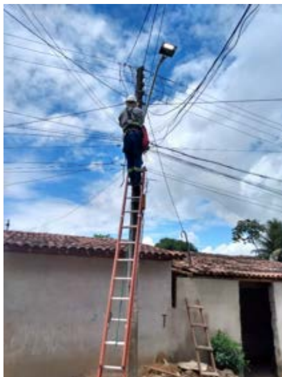
Figura 33 - Troca do conjunto de IP auxiliado por escada
