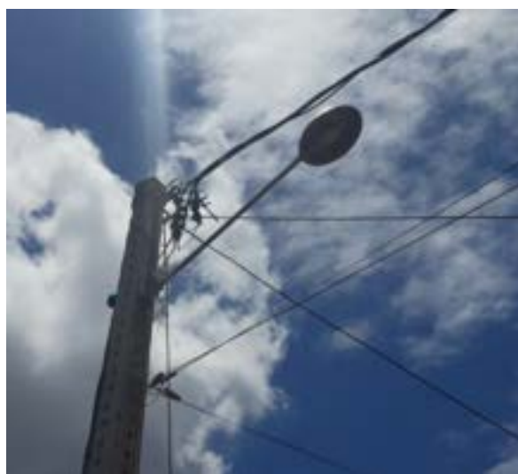
Figura 14 - Luminária aberta de Paudalho-PE
