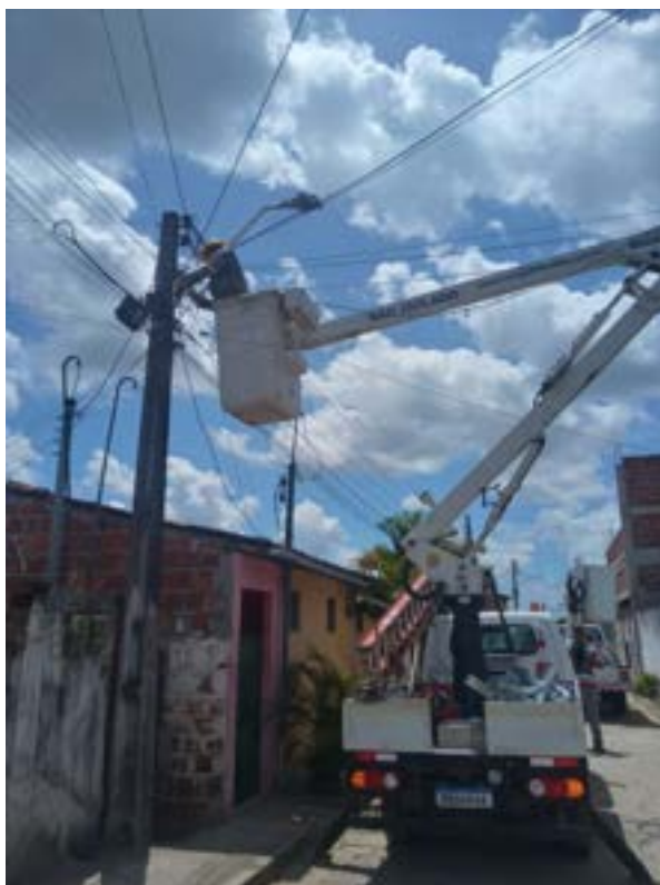
Figura 31 - Instalação do novo conjunto de IP
