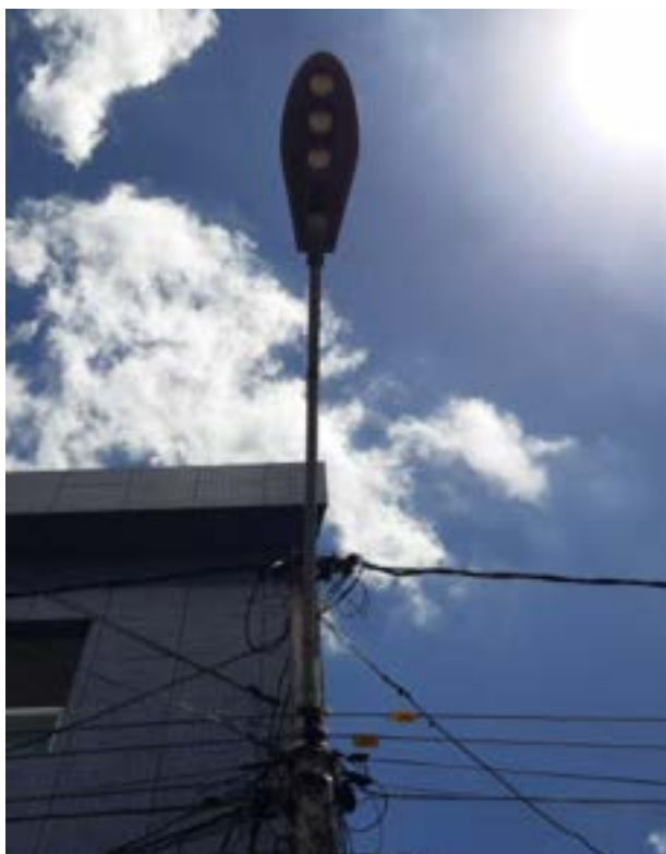
Figura 15 - Luminária fechada Paudalho-PE
