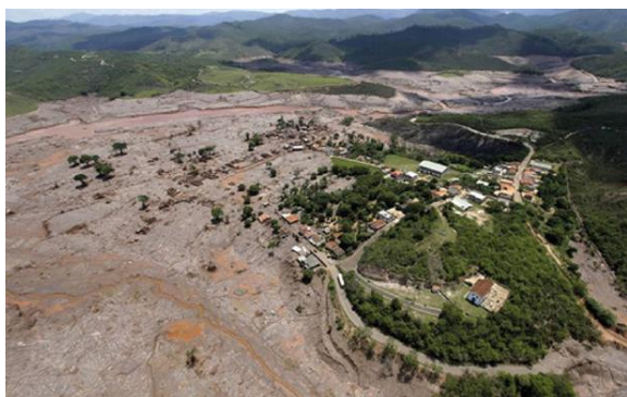
Figura 02 – Devastação do distrito de Bento Rodrigues
