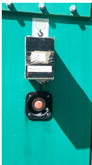
Figura 24 – Nó TX02 instalado no gerador.
