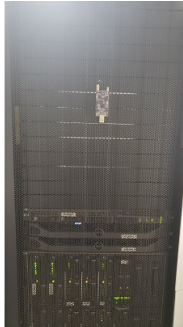
Figura 27 – Nó TX04 fixado no rack.
