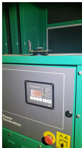
Figura 21 – Nó transmissor no gerador.
