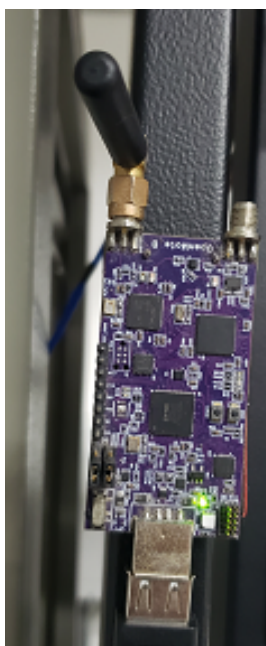
Figura 23 – Nó TX03 instalado no rack.
