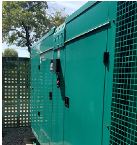
Figura 25 – Nó TX02 instalado no gerador (visão geral).
