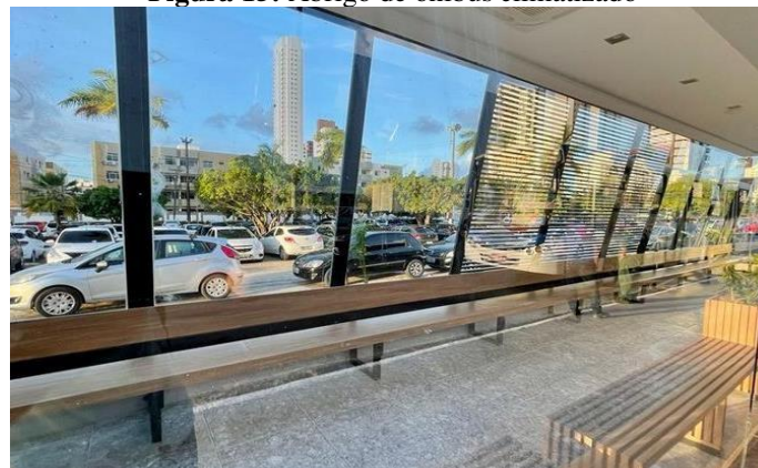
Figura 15: Abrigo de ônibus climatizado
