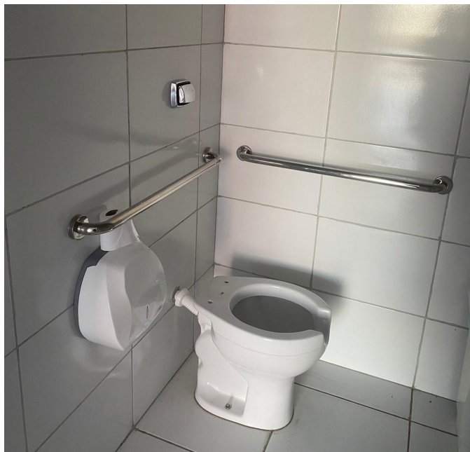
Figura 10 - Sanitário do WC PCD.
