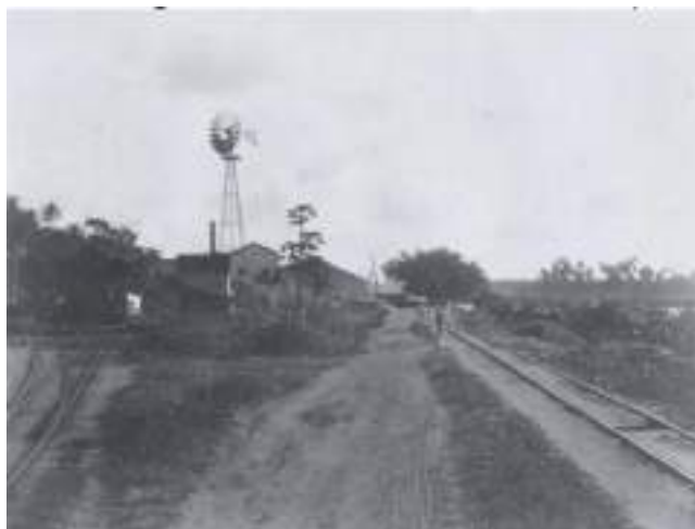
Figura 15: Ferrovia próxima ao Rio Sanhauá, 1920.
