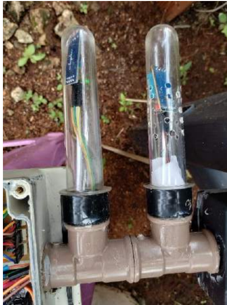
Figura 29 - Torres plásticas para proteção dos sensores
