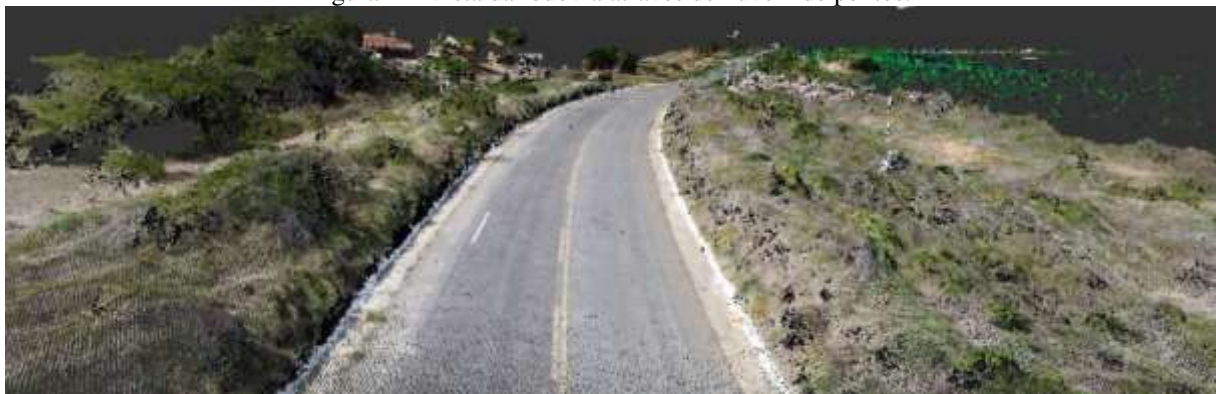
Figura 4 – Vista da rodovia através de nuvem de pontos.
