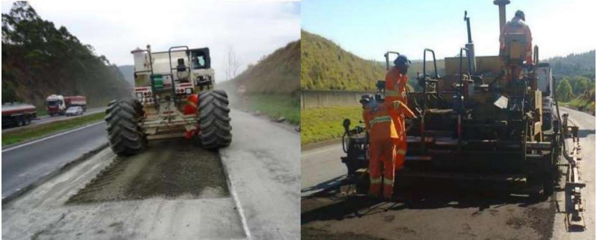
Figura 29 – Fresagem e recapeamento da rodovia.
