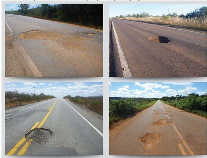
Figura 14 – Manifestação patológica tipo panela ou buraco.
