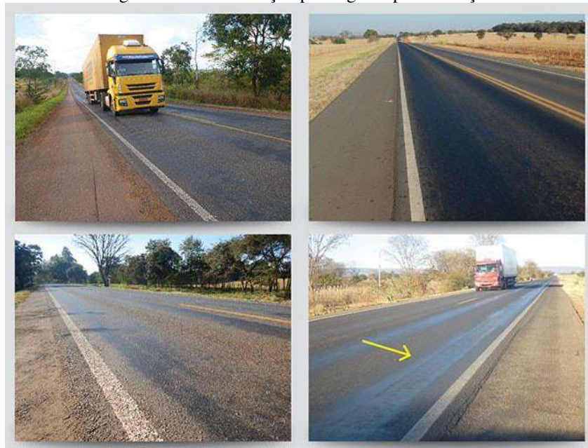
Figura 12 – Manifestação patológica tipo exsudação.
