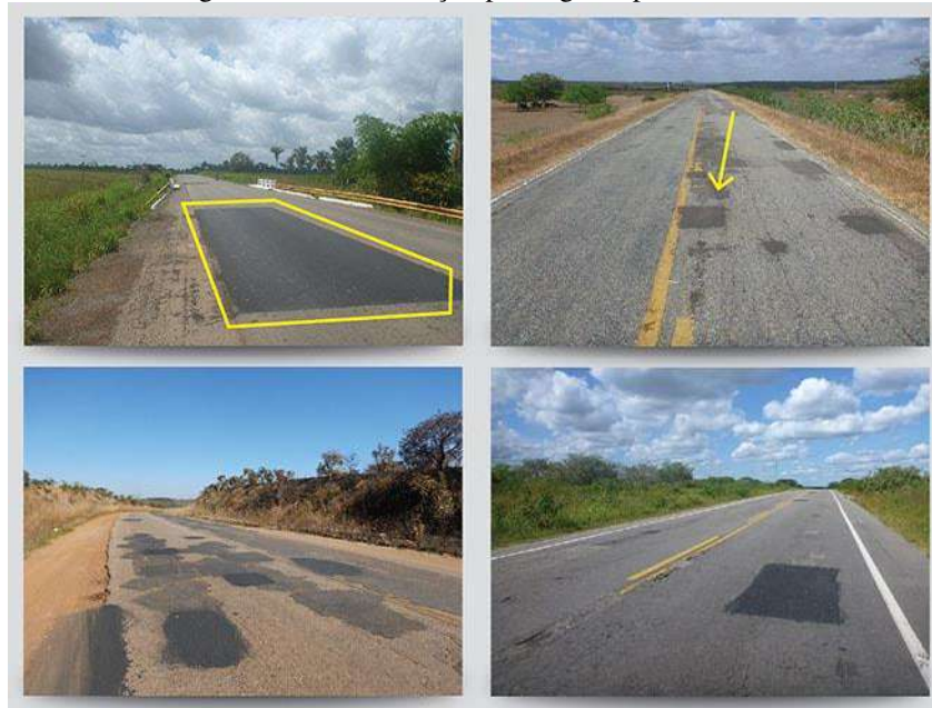
Figura 15 – Manifestação patológica tipo remendo.
