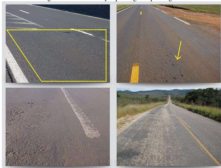
Figura 13 – Manifestação patológica tipo desgaste.
