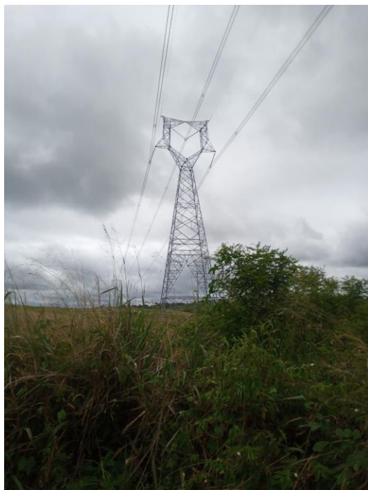
(a) estrutura autoportante
