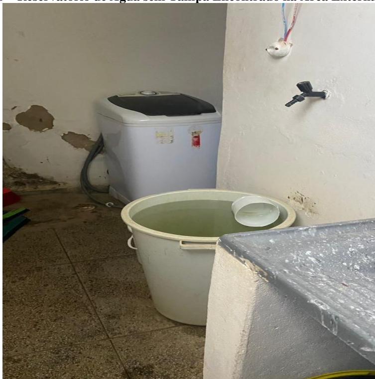
Figura 6 – Reservatório de Água sem Tampa Encontrado na Área Externa da USF.
