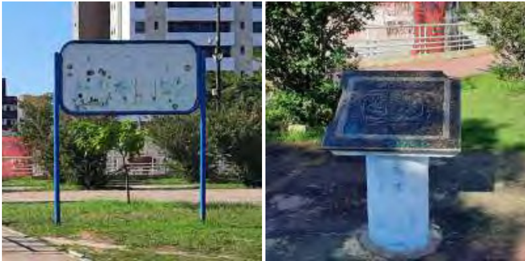
Figura 13. Placas deterioradas na Praça da Paz.
