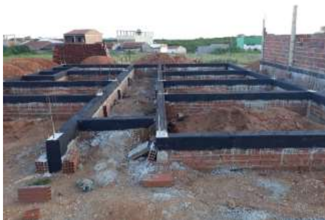
Figura 15 - Impermeabilização da viga baldrame com massa asfáltica.
