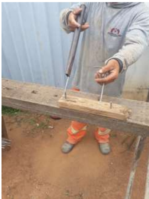
Figura 8 - Confeção de armaduras.
