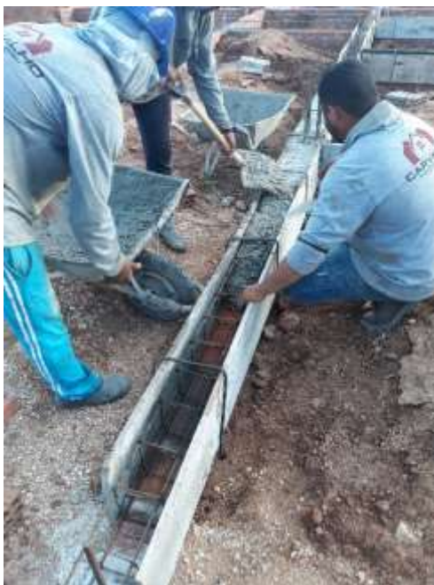
Figura 13 - Concretagem da viga baldrame.
