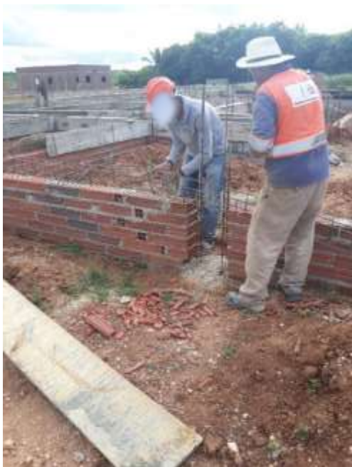
Figura 12 - Colocação das armaduras.
