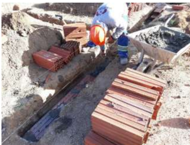
Figura 6 - Regularização com alvenaria de embasamento para execução da viga baldrame.
