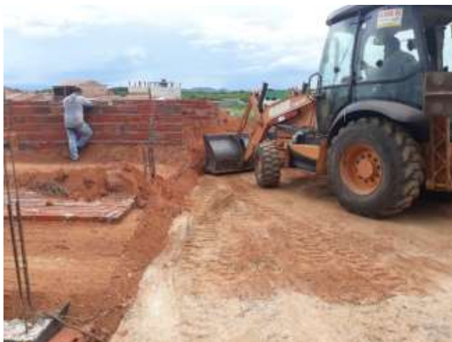
Figura 16 - Execução de Aterro com terra vermelha.
