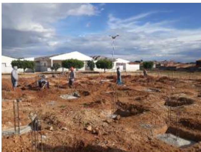
Figura 2 - Sapatas isoladas executadas.
