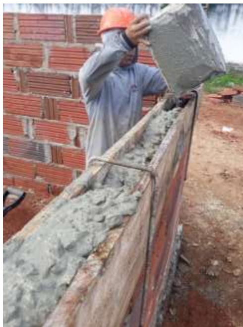
Figura 20 - Concretagem das treliças, das contra vergas.
