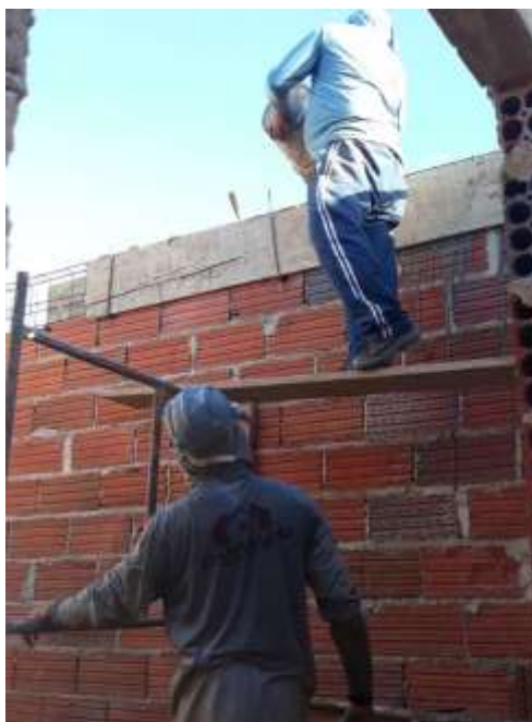
Figura 28 - Concretagem das vigas.
