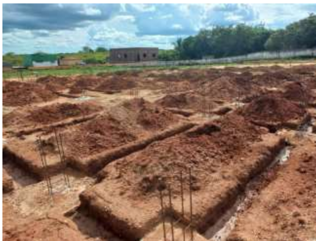
Figura 5 - Escavação de Valas para execução das vigas baldrame.
