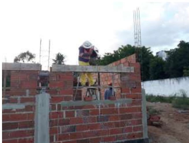
Figura 22 - Concretagem das vergas.
