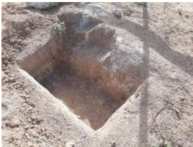
Figura 3 - Escavação da sapata nº06 não executada.
