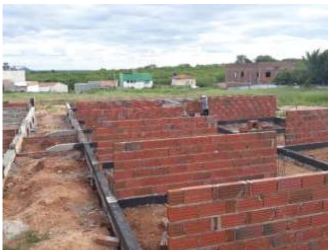
Figura 19 - Execução de alvenaria de fechamento.
