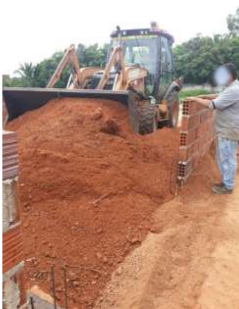
Figura 17 - Execução de Aterro com terra vermelha.
