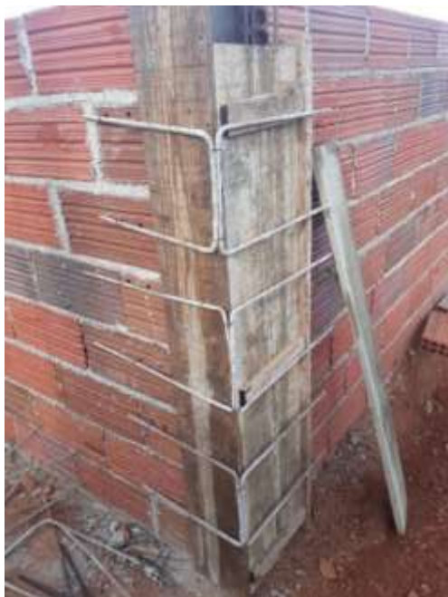
Figura 24 - Colocação das formas dos pilares.
