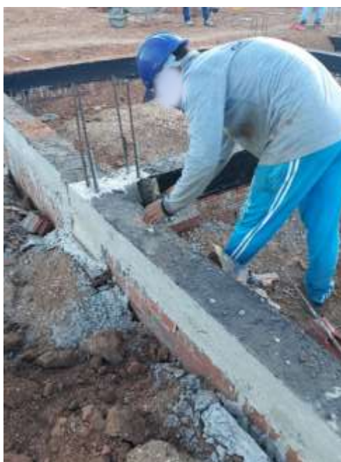
Figura 14 - Impermeabilização da viga baldrame com massa asfáltica.
