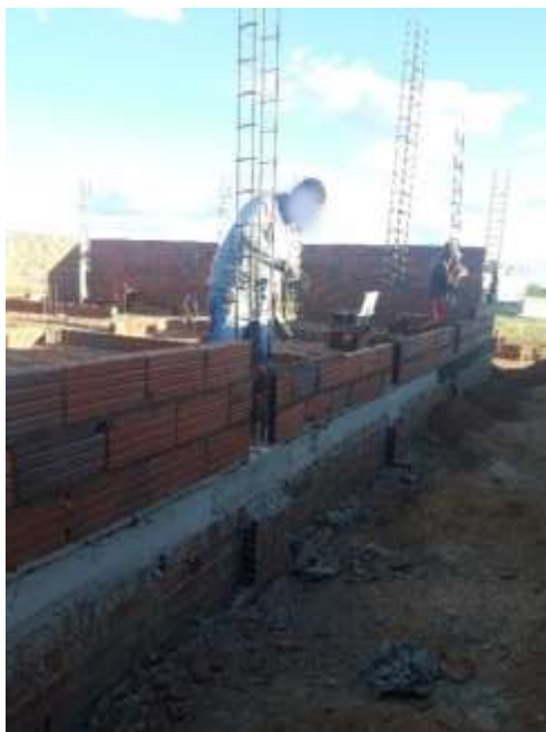
Figura 18 - Execução de alvenaria de fechamento.
