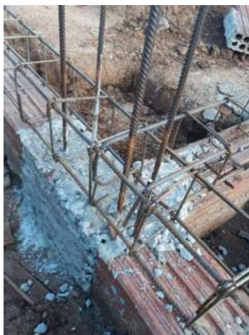
Figura 10 - Ancoragem de armaduras da viga baldrame.
