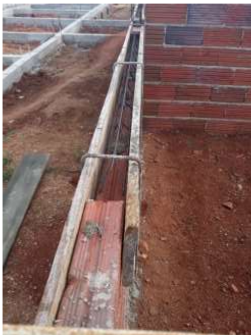
Figura 21 - Colocação de formas das contra vergas.
