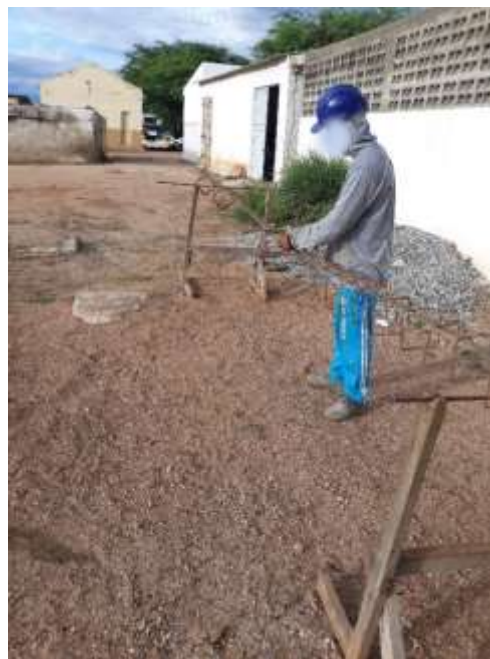
Figura 9 - Confeção de armaduras.
