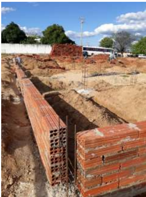
Figura 7 - Nivelamento da Fundação para execução da viga baldrame.
