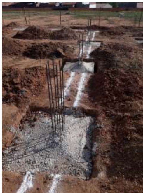
Figura 4 - Marcação para a escavação das valas.
