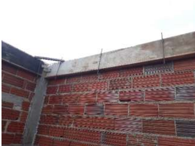
Figura 27 - Colocação de formas das vigas.
