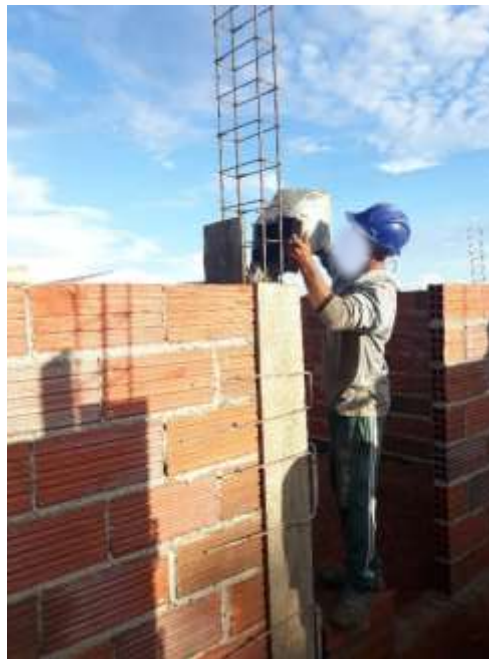
Figura 25 - 1º etapa da concretagem dos pilares.
