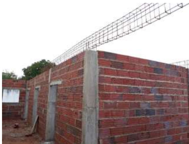
Figura 26 - 2º etapa da concretagem dos pilares concluída.
