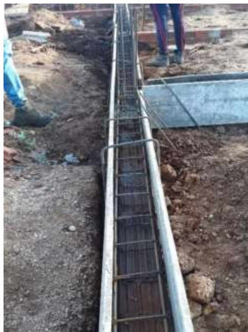
Figura 11 - Colocação das formas.
