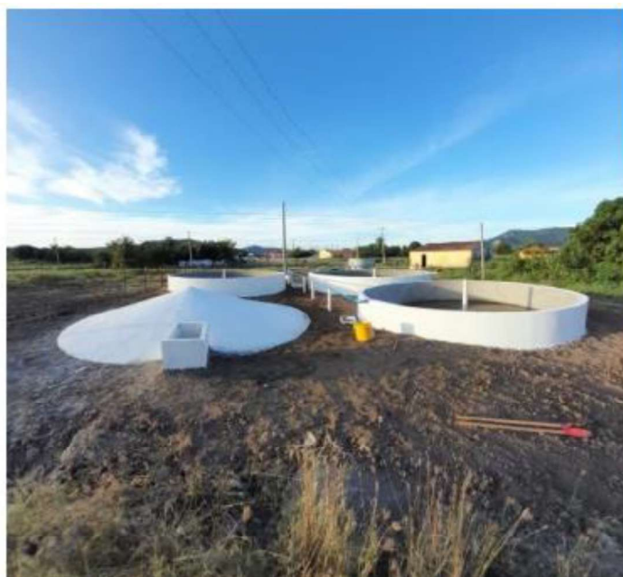
Figura 6: Estrutura do SARA executada (Autor)
