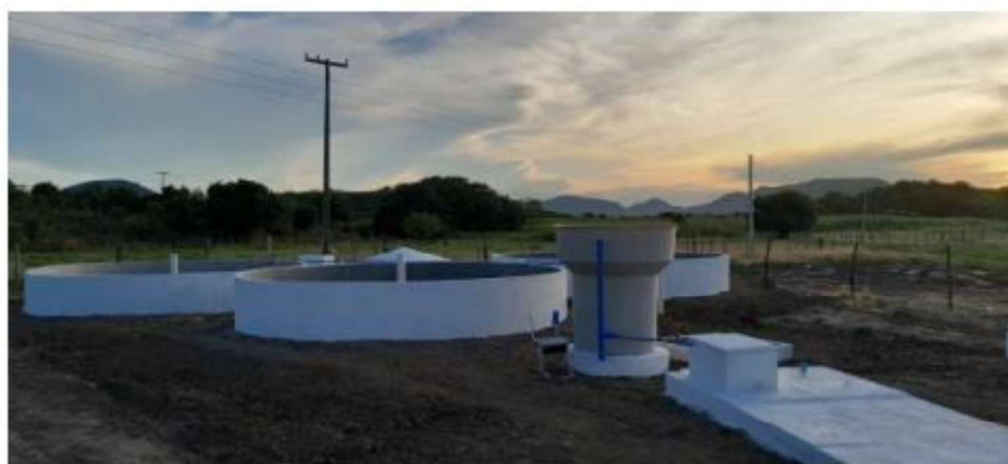
Figura 5: Estrutura do SARA executada (Autor)
