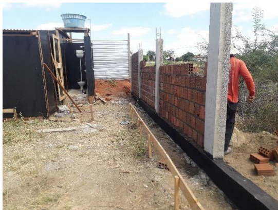
Figura 7 – Detalhe da execução da alvenaria de fechamento
