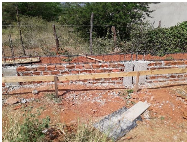
Figura 4 – Detalhe da junção de dois pilares do muro
