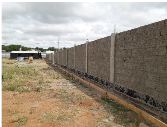
Figura 8 - Detalhe do revestimento do muro com chapisco
