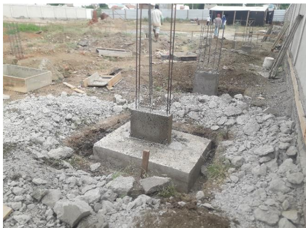
Figura 11 – Detalhe da fundação tipo sapata isolada
