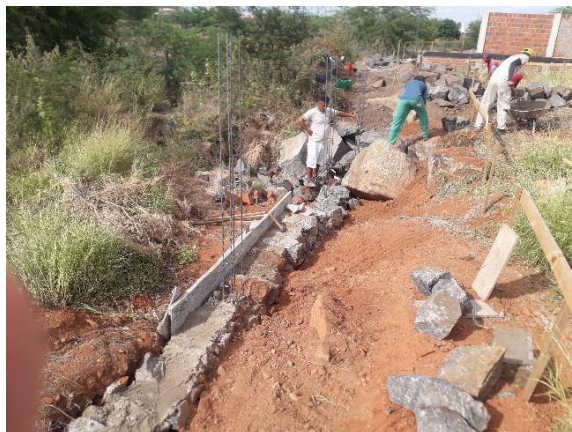
Figura 5 – Detalhe da fundação de pedra
