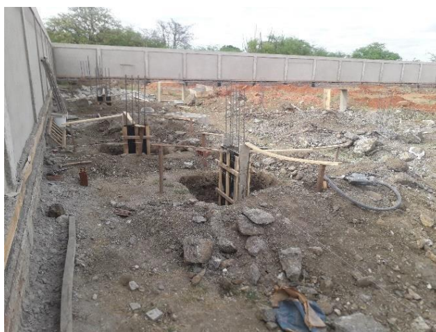
Figura 10 - Formas e concretagem da fundação
