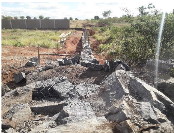
Figura 6 – Detalhe da fundação reforçada de pedra e concreto
