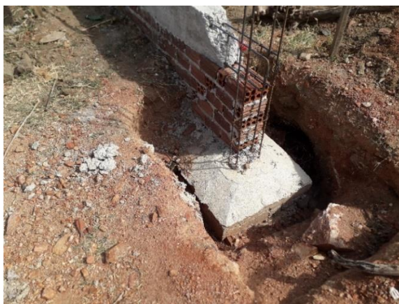
Figura 3 - Execução da fundação e viga baldrame do muro da fachada
