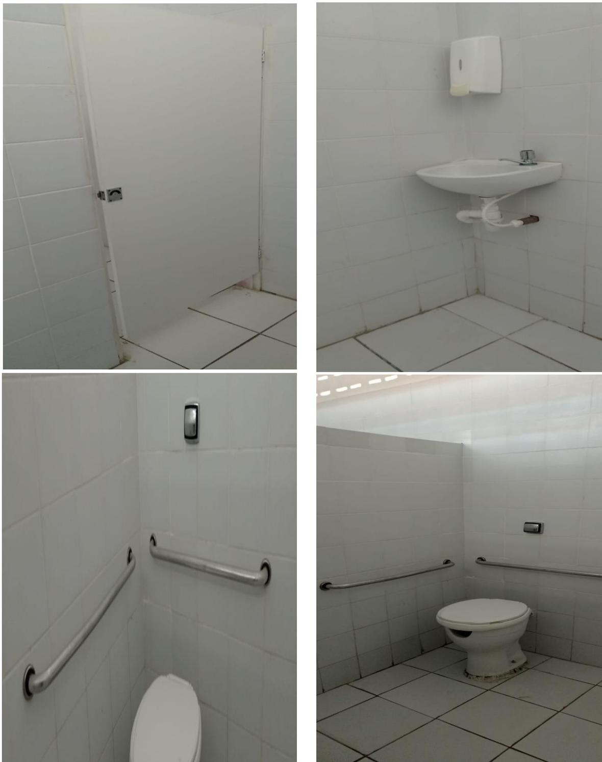
**Figura 19: Porta, lavatório, bacia e barra de apoio do banheiro adaptado da Escola Maria Bezerra da Silva.
