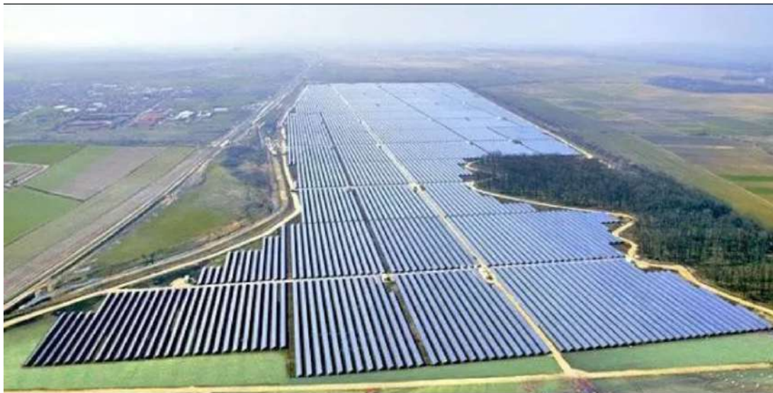
Figura 3 — Usina fotovoltaica de grande porte localizada no Piauí.
