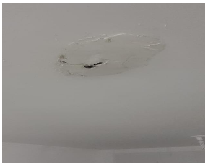
Figura 4 - Perfuração do forro de gesso
