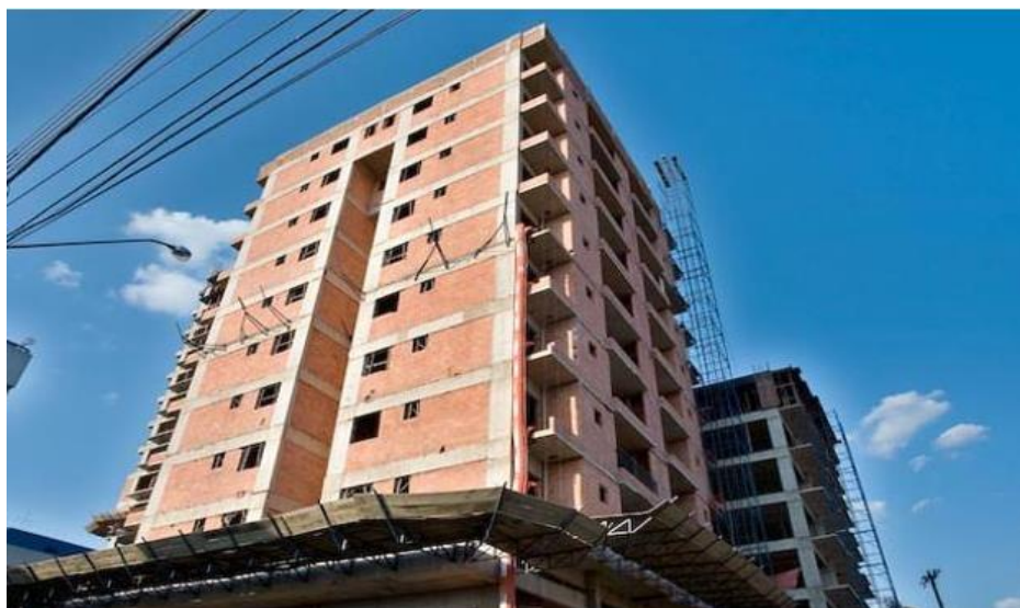
Figura 15 - Prédio em alvenaria convencional
