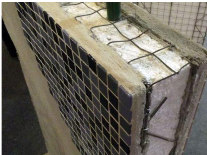
Figura 6 – EPS revestido com aço e concreto
