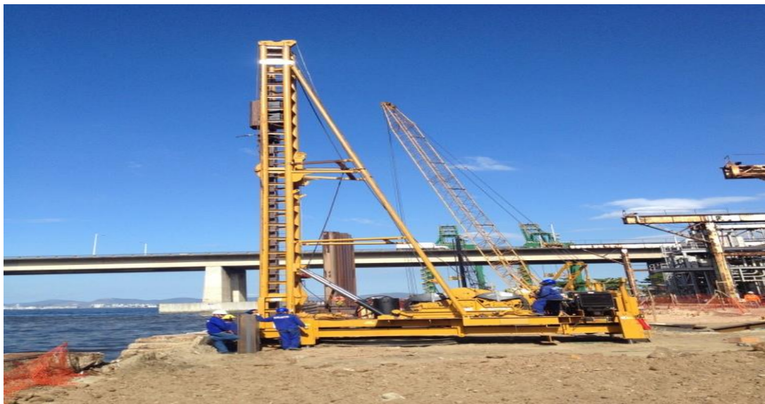
FIGURA 9- Bate-estacas
