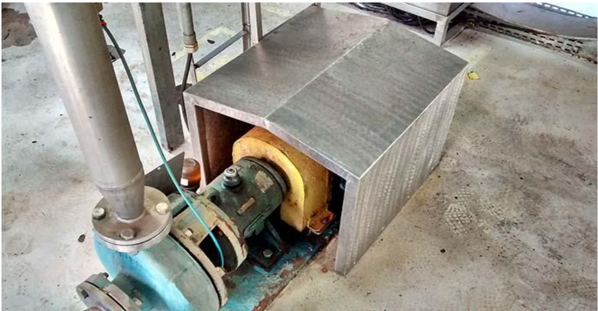
FIGURA 4: Isolamento acústico na fonte
