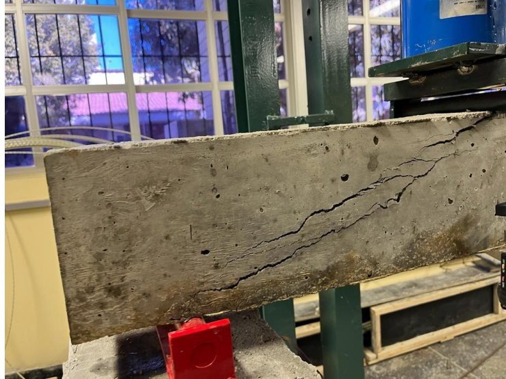
Figura 14 - Fissuras após ruptura por cisalhamento, V2A.
